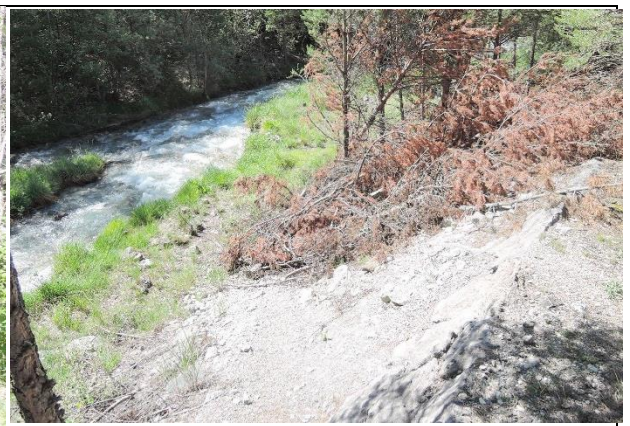
Chenal amont : végétation ligneuse envahissant le lit et les ouvrages de protection des berges. Photos RTM 14/06/2018
