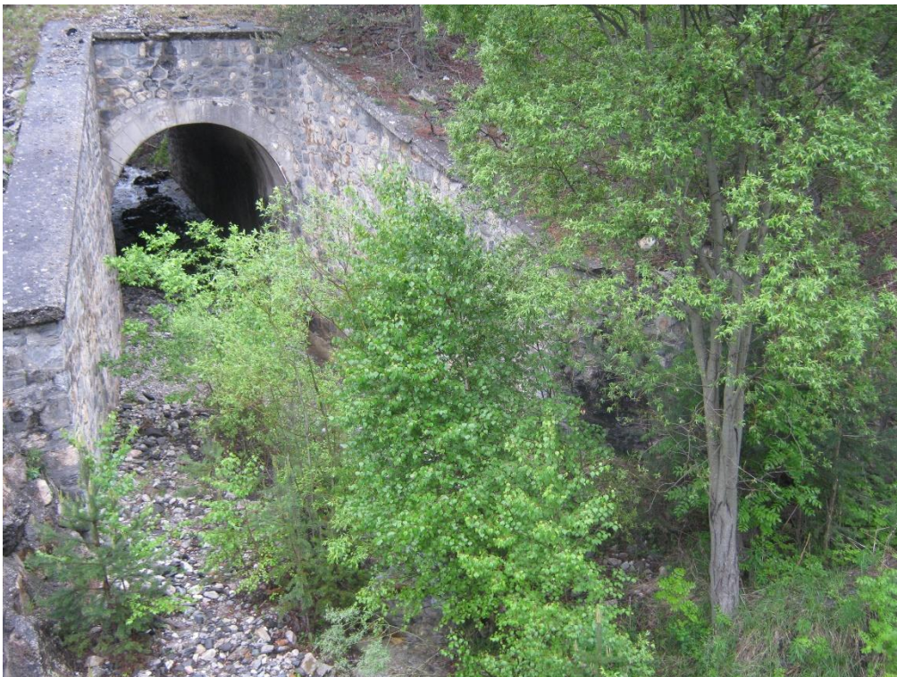
Vue vers l'amont : vieux pont sur l'ancien tracé de la RN94 ; végétation à éliminer entre les deux ouvrages
