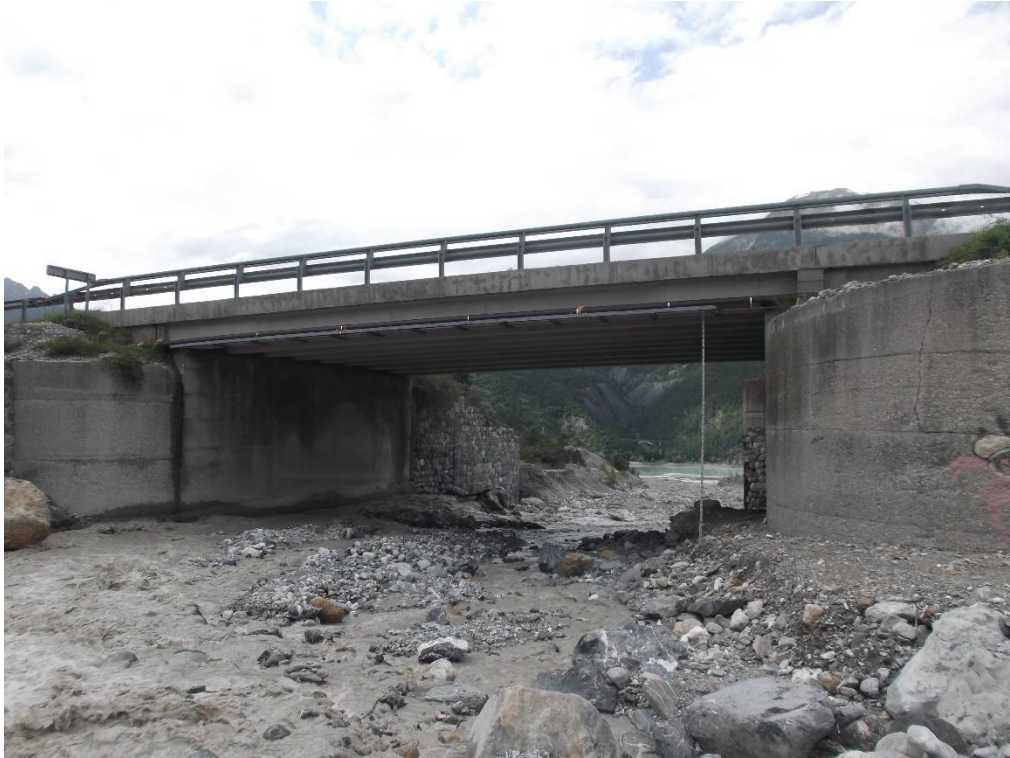
Section amont du pont de la RN – hauteur du tirant : 4,70 mètres – 11/06/2018
