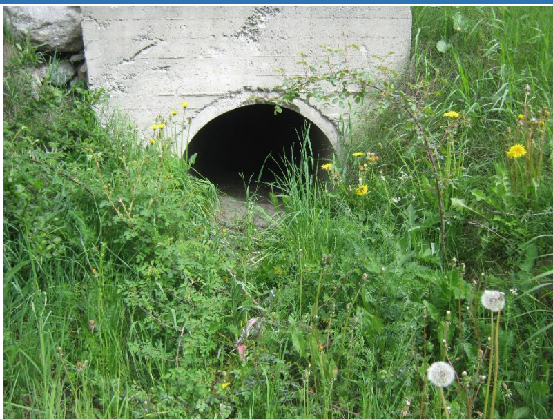
Juin 2018- Sortie aval du passage busé légèrement comblé du fait de la pente faible à l'aval
