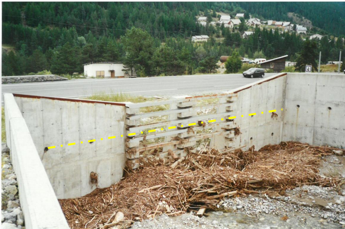
Après la crue du 24/07/1995. Très bon fonctionnement de l'ouvrage : les flottants sont bien été piégés ; La ligne indique la hauteur atteinte au paroxysme de la crue
