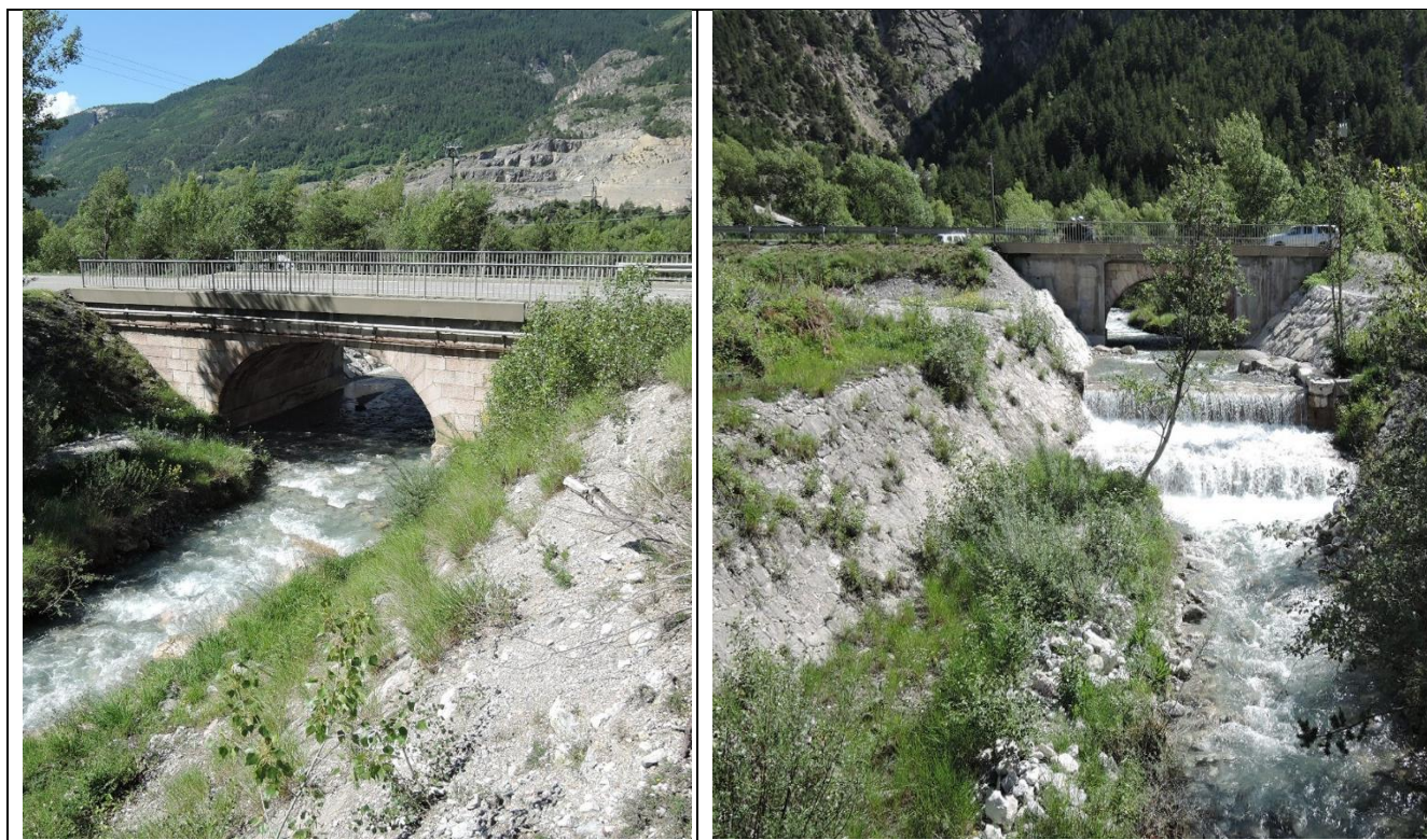
Amont : digues parement incliné – Photos RTM 14/06/2018 – Aval : chenal et seuils en amont voie ferrée
