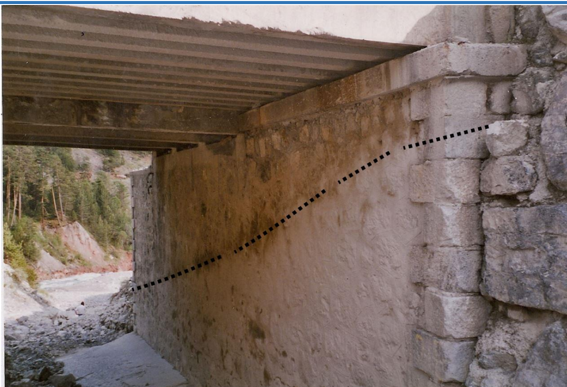
Crue du 18 juin 2002 . traces de passage de lave torrentielle sur la culée droite du pont
