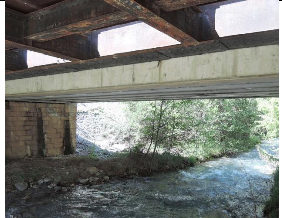
Amont pont voie ferrée avec berges au parement incliné – Photos RTM 14/06/2018 – Renforcement tablier H - 35cm
