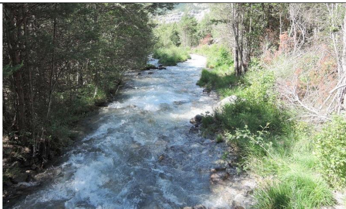
Chenal amont : végétation ligneuse envahissant le lit et les ouvrages de protection des berges. Photos RTM 14/06/2018
