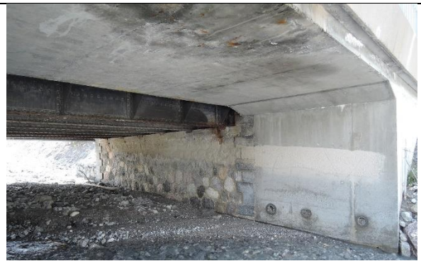
Amont pont restes de gabions et dépôts matériaux - RTM 12/06/2018 - Poutres limitant la section à l'amont
