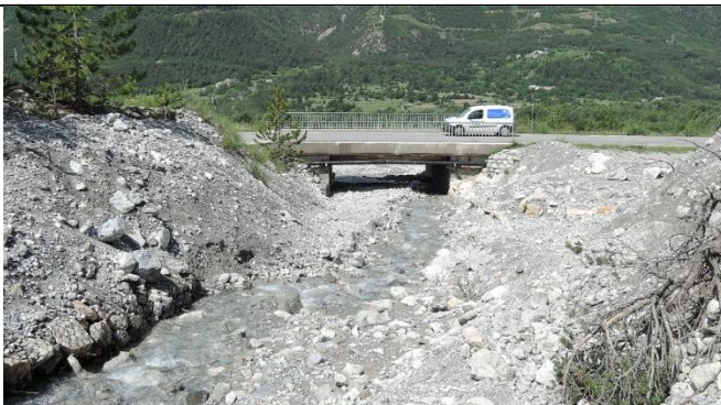
Amont pont restes de gabions et dépôts matériaux - RTM 12/06/2018 - Poutres limitant la section à l'amont
