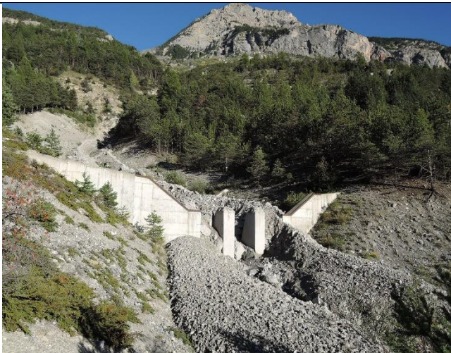
Plage de dépôt après la crue du 14/09/2015 – Photo RTM 20/09/2015 – Zone de dépôts aval PDD et chenal aval
