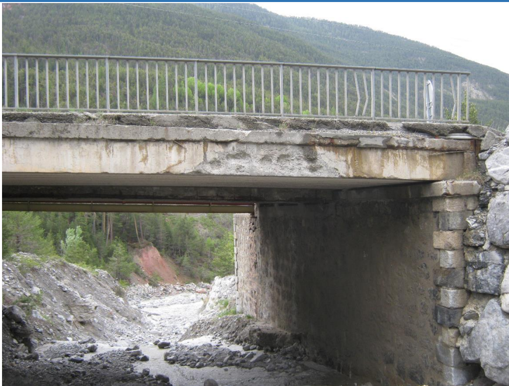
Année 2018_ Tablier du pont avec impacts des chocs lors des crues à lave
