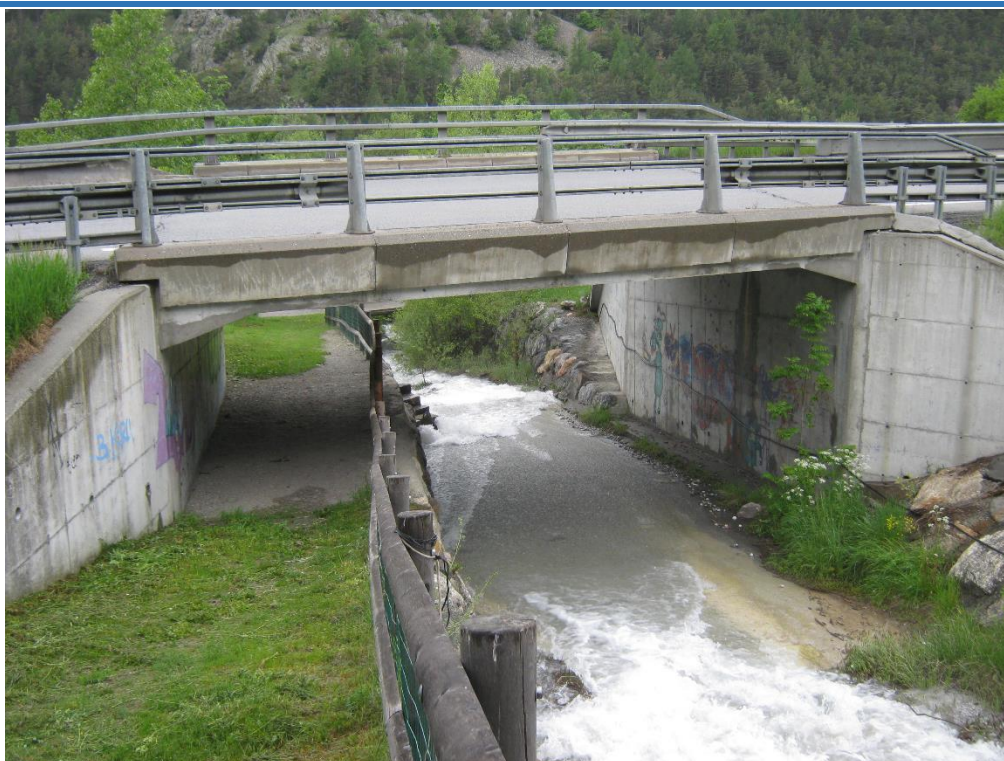
Le pont sur la RN 94 (déviation de ST Martin de Queyrières) avec son radier d'accélération et le passage piétonnier
