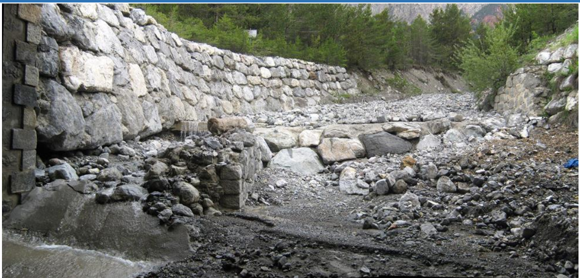
Protection de la berge droite à l'amont du pont légèrement affouillée. On remarque les fondations de l'ancienne culée du vieux pont au milieu du lit ainsi que le seuil transversal de protection de la conduite EP de Briançon à l'amont.
