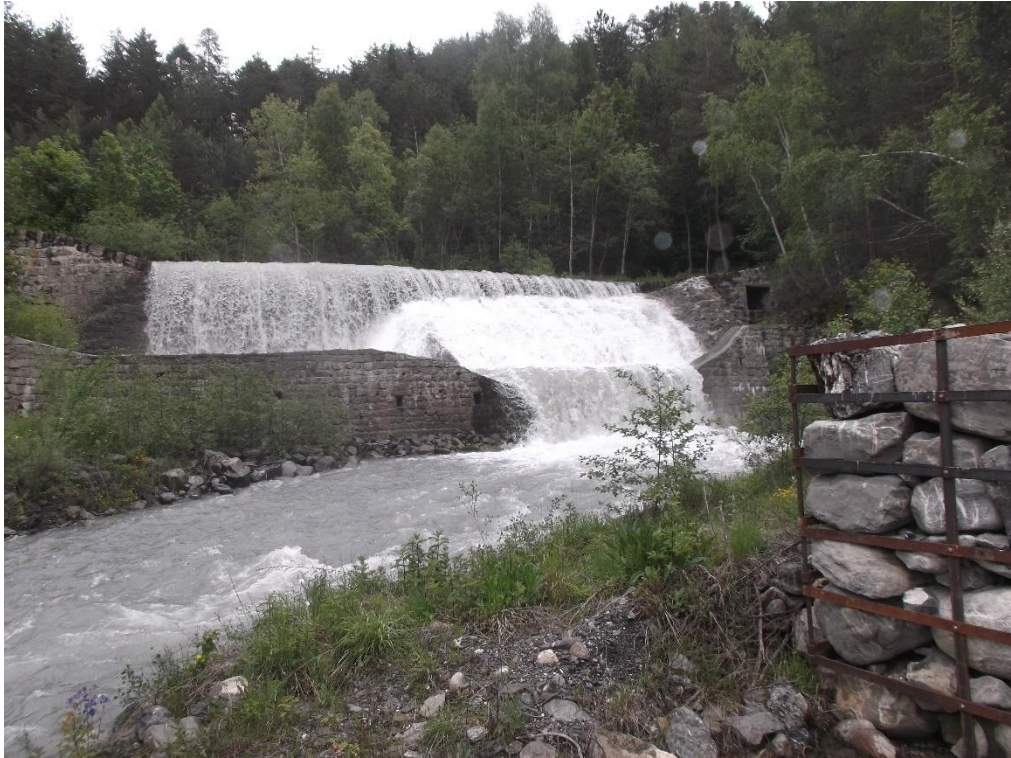
Barrages de correction torrentielle dans le chenal d'écoulement du Vachères
