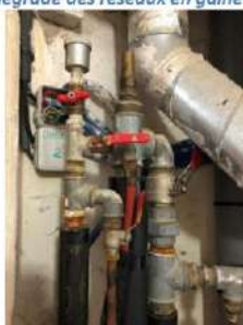
Haut de colonne de gaine technique (Purgeur et antibélier, Bouclage non calorifugé)
