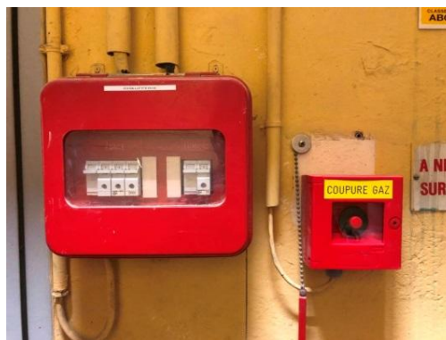
Dispositifs de Coupure électrique / gaz
