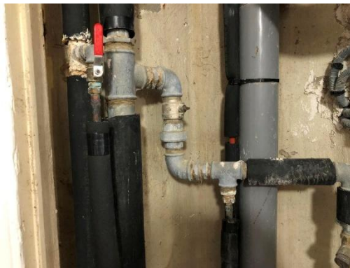
Etat dégradé des réseaux en gaine technique
