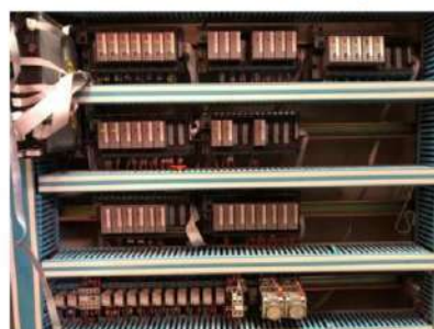
Cartes E/S et passerelle GTC
