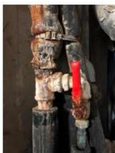
Etat dégradé des réseaux en gaine technique
