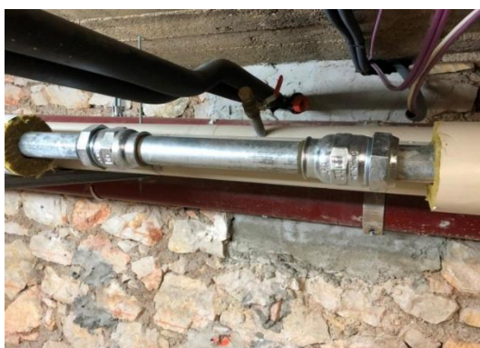
Réparation sur collecteur principal en galerie technique
