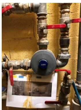
Mitigeur central en sortie de production (Hors service)
