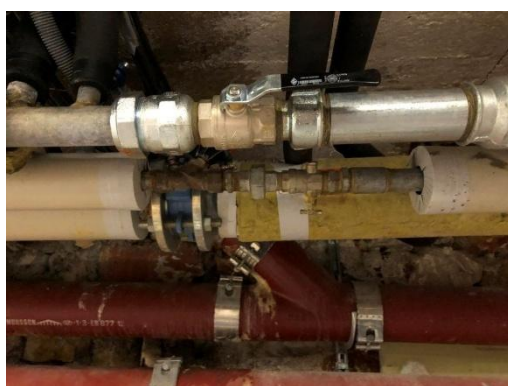
Réparations sur collecteur ECS en galerie technique
