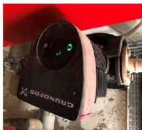
Pompe de charge chaudière
