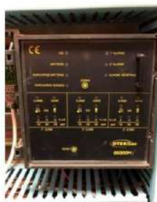
Centrale de détection
