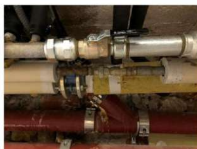
Réparations sur collecteur ECS en galerie technique
