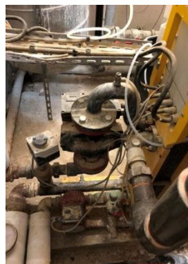
Circulateur/Vanne de régulation
