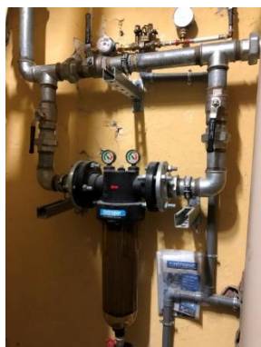
Filtre à tamis filtrant CINTROPUR
