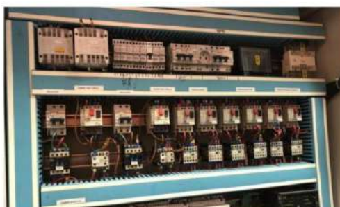
Protections et contacteurs Courants forts
