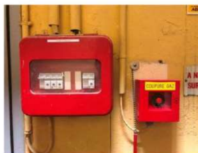
Dispositifs de Coupure électrique / gaz
