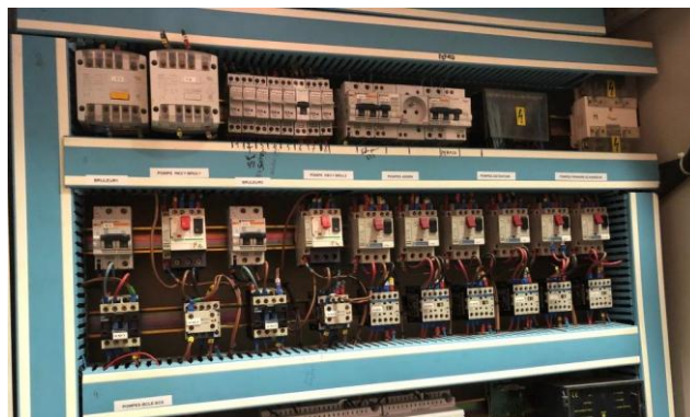
Protections et contacteurs Courants forts
