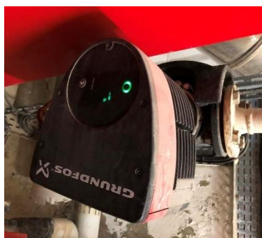
Pompe de charge chaudière
