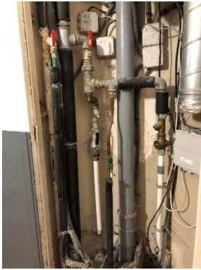
Gaine technique desservant deux cellules
