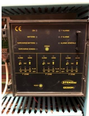
Centrale de détection
