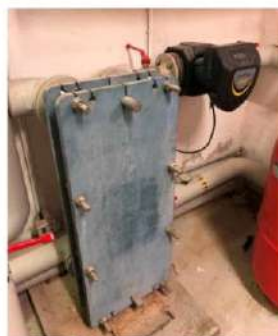
Echangeur Primaire chauffage
