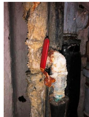
Etat dégradé des réseaux en gaine technique
