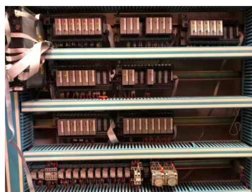
Cartes E/S et passerelle GTC
