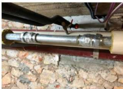
Réparation sur collecteur principal en galerie technique
