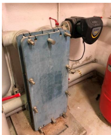
Echangeur Primaire chauffage
