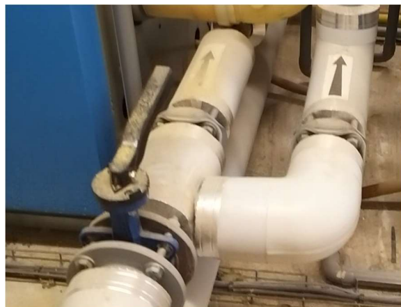
Calorifuge des réseaux par laine minérale avec revêtement PVC
