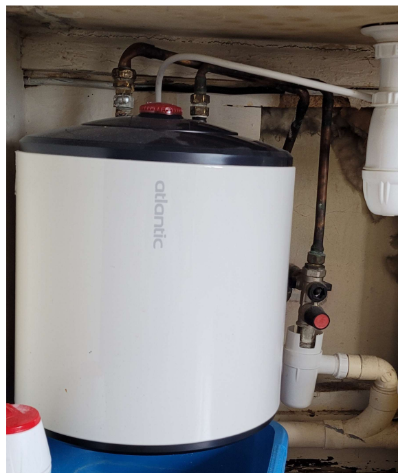
Ballon de d'eau chaude électrique
