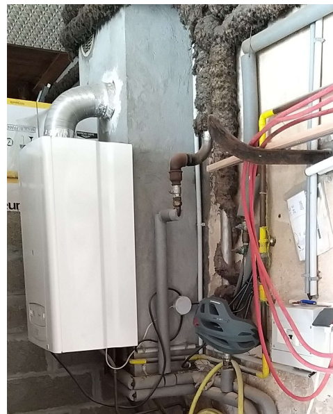
Calorifuge des réseaux par laine minérale avec revêtement PVC
