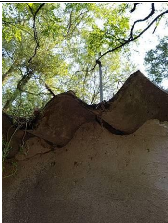
Photo Prélèvement 08 : plaque ondulée Localisation : 1° étage - Toiture WC
