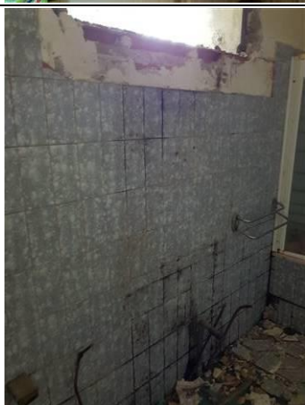
Photo Prélèvement 06 : colle faïence murale Localisation : RDC - Salle de bain / WC
