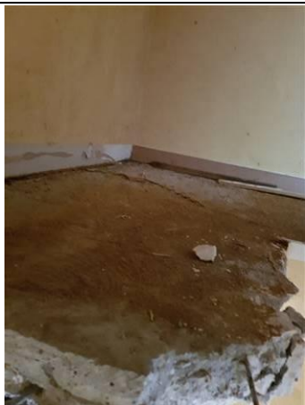
Photo Prélèvement 09 : colle jonc de mer + dalle béton Localisation : 1° étage - Chambre
