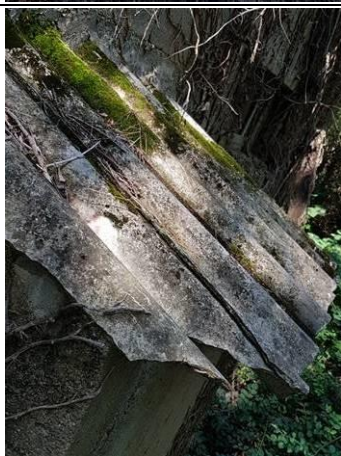
Photo Prélèvement 02 : plaque ondulée Localisation : 1° étage - Toiture local
