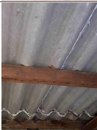
Photo Prélèvement 07 : plaque ondulée Localisation : 1° étage - Toiture maison
