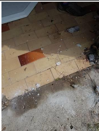
Photo Prélèvement 01 : colle carrelage + ragréage + dalle béton Localisation : RDC - Local 1
