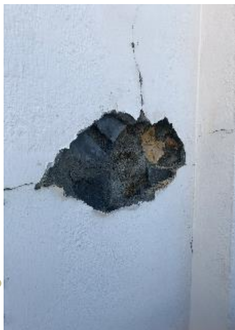
Sondage sur fissure : mélange enduits ciment & ardoise - présence d'eau
