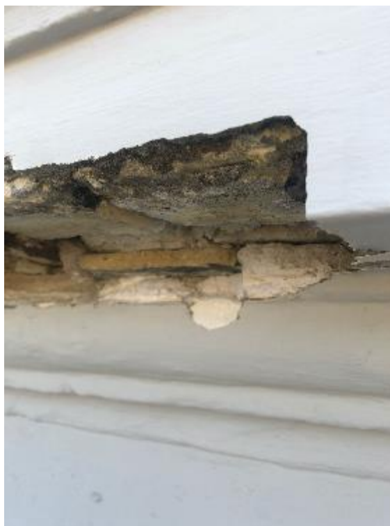
Mélange plâtre, enduits chaux, ciment, brique
