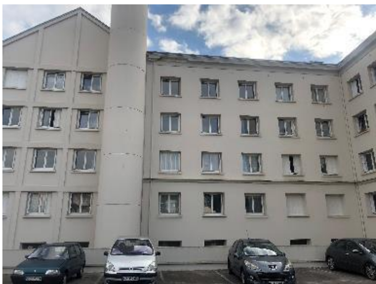
Corniches dégradées en façade Nord - bât E
