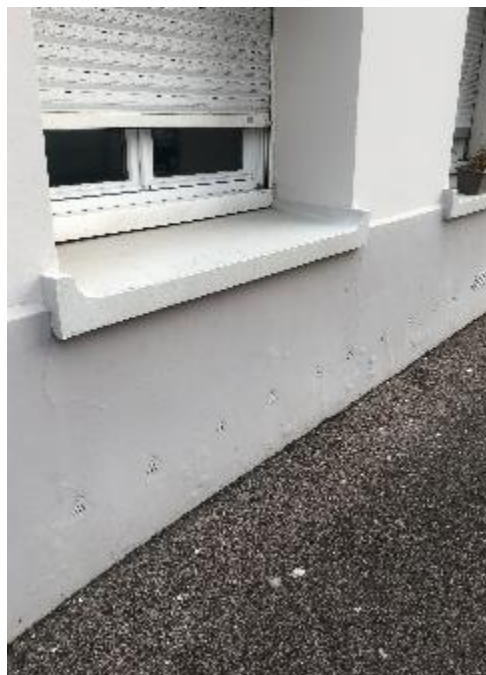
Remontées capillaires: cloques et fissures sur la hauteur des Rez-de-chaussée
