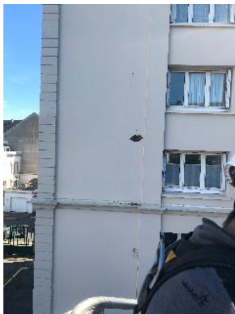
Sondage sur fissure : mélange enduits ciment & ardoise - présence d'eau
