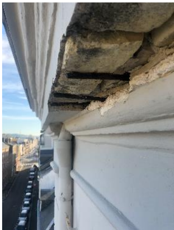
Fers rouillés en sous-face des briques
