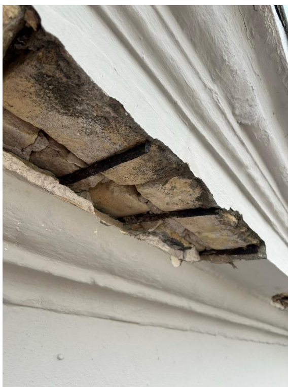
Briques de vase maintenues par des aciers (très corrodés) La corrosion importante de ces aciers est à l'origine de la chute de la partie basse des acrotères
