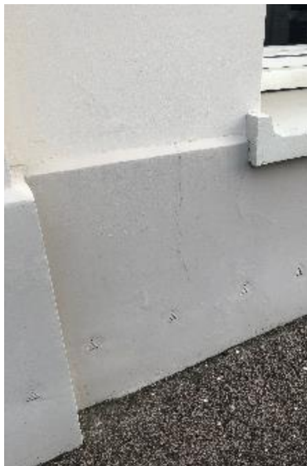
Remontées capillaires: cloques et fissures sur la hauteur des Rez-de-chaussée
