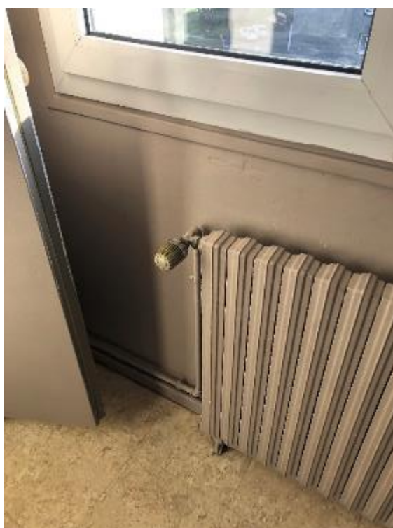
Radiateur équipé de robinet thermostatique vétuste
