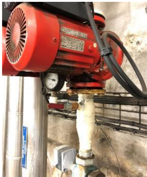
Circulateur chauffage fuyard
