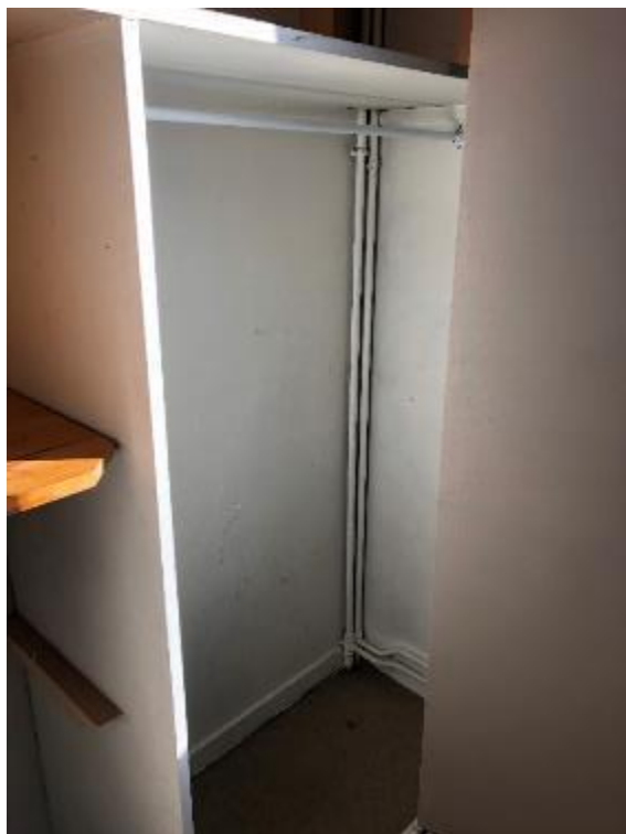
Distribution chauffage bitube en logement
