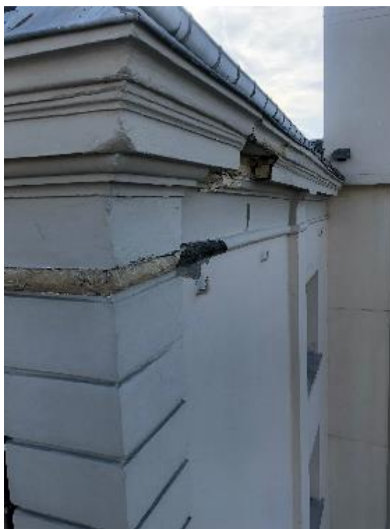
Pierre avec réparation en ciment
