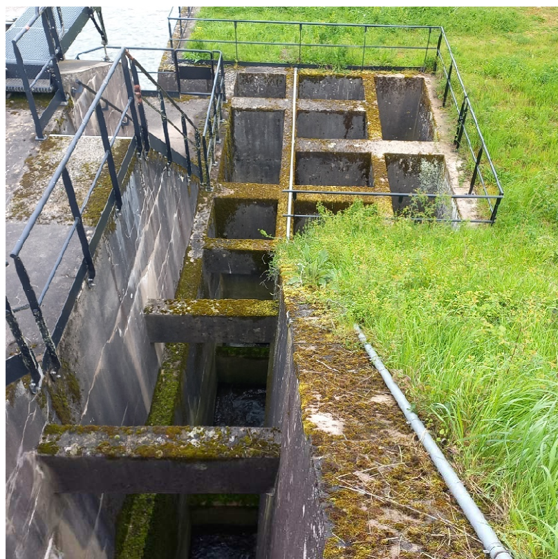
Passe à poissons existante : entrée hydraulique de la passe
