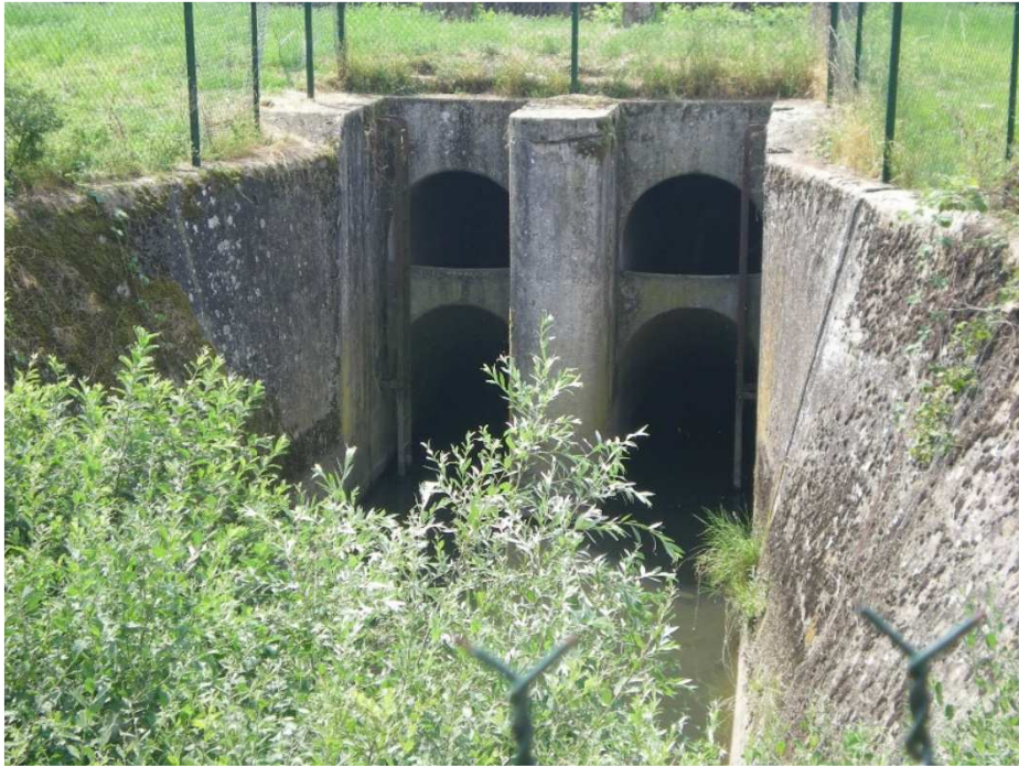
Ruisseau de la Feigne – passage en siphon sous le canal
