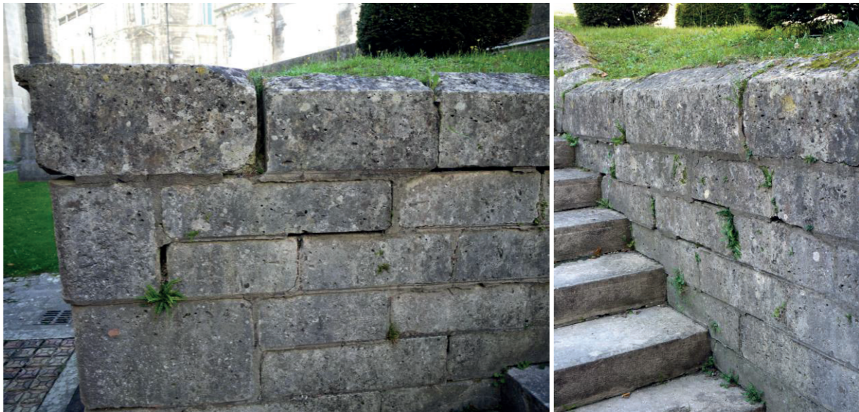
Escalier dans l'axe de l'édicule Nord : éclatement des joints et déchaussement des pierres sous la poussée des buttes de terre
