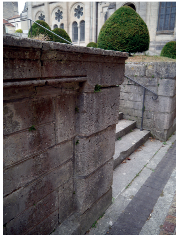
Détail du mur déformé par les poussées
