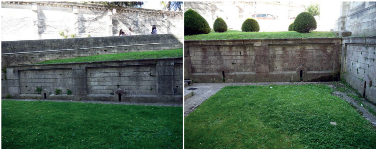
L'ensemble des parties hautes a bougé sous la poussée des buttes de terre, créant un décalage successif des assises vers le Sud. Les joints ont éclatés, permettant à la végétation de se développer.
