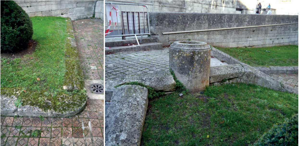
parapets de jardin dégradés par le ruissellement et les intempéries
