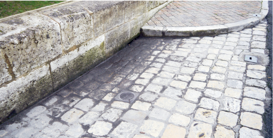
Ancien rampe d'accès murée avec stagnation des EP
