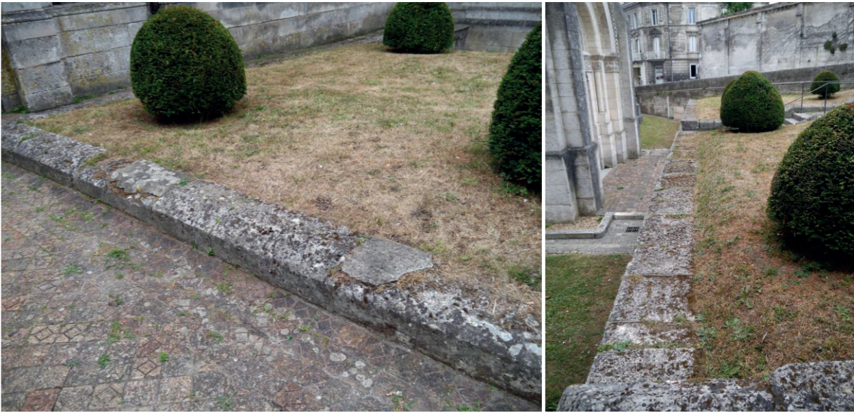
Les parterres du jardin ont connus différentes époques d'entretien et de plantation qui ont accumulé de la terre végétale, créant des buttes sur ces parterres. Celles-ci appuient sur les murs de soutènement déjà fragilisés par les systèmes racinaires successifs. La terre déborde aussi au-dessus des parapets sensés délimiter les parterres, créant un ruissellement des eaux de surface par temps de pluie.
