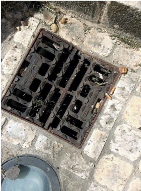
Détail des tampons industriels inadaptés
