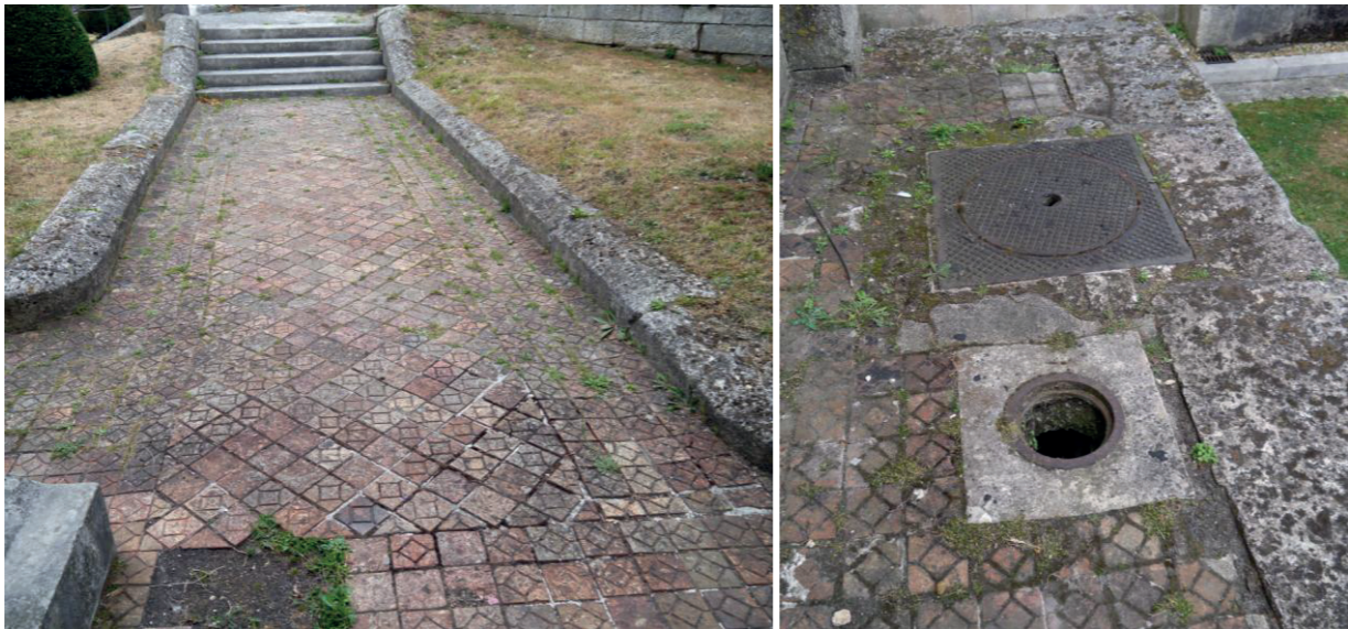
Sols en carreaux de terre cuite avec casses et lacunes (restaurations au ciment avec reprise du motif)
