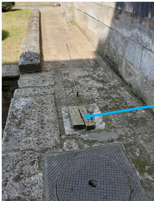
Arrivée lave main n°1 Sacristie des Messe dans le caniveau maçonné en amont du Puits
