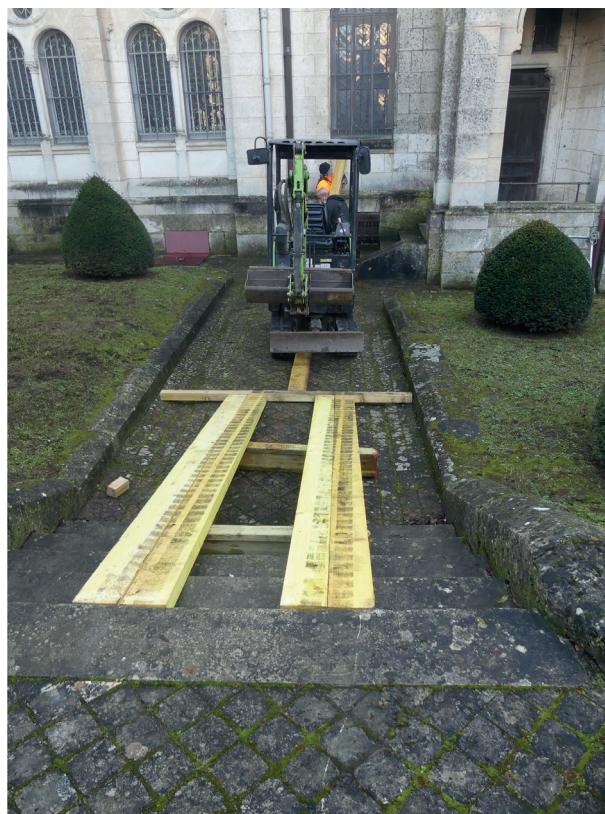
Fig. 16 Conditions d'accès pour la réalisation des sondages 1 et 2 (cliché 207742.084)
