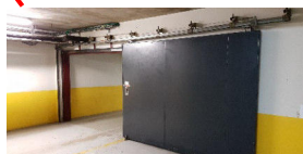
Cordon situé sur la chicane de guidage de la porte coupe-feu
