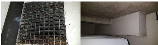
Gaine de ventilation haute en amiante-ciment
