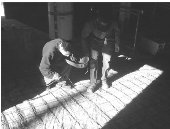
Figure 2 : Soudage du treillis
