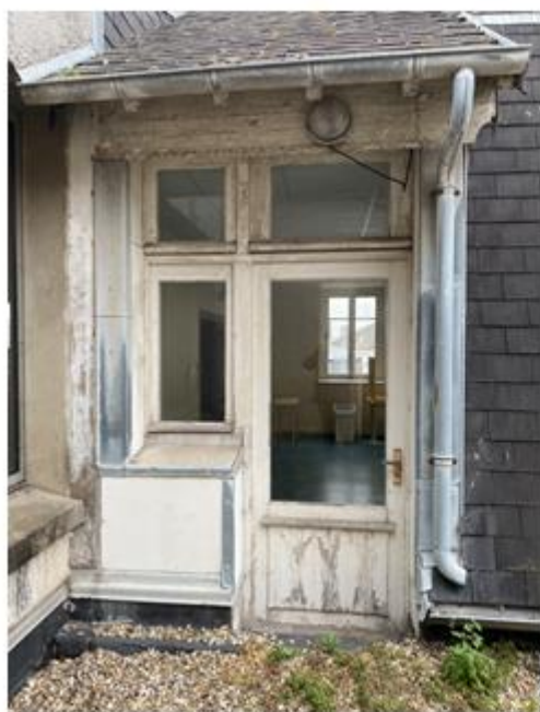
Vue portes et chassis avec toiture et joues à remplacer pour la pose des nouvelles menuiseries (totalité des portes et menuiseries du patio extérieur R+3)
