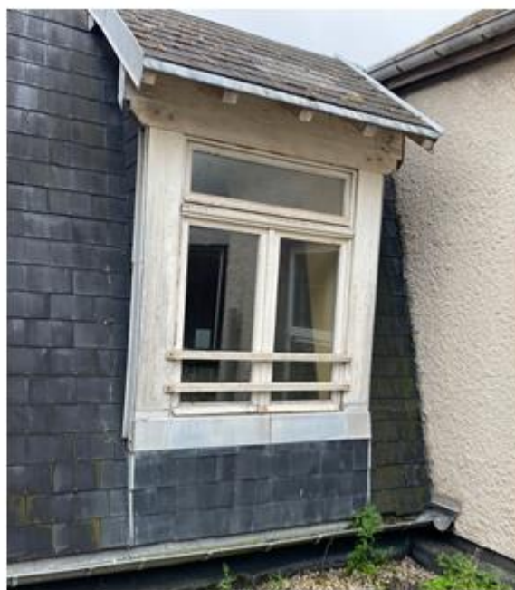
Vue portes et chassis avec toiture et joues à remplacer pour la pose des nouvelles menuiseries (totalité des portes et menuiseries du patio extérieur R+3)
