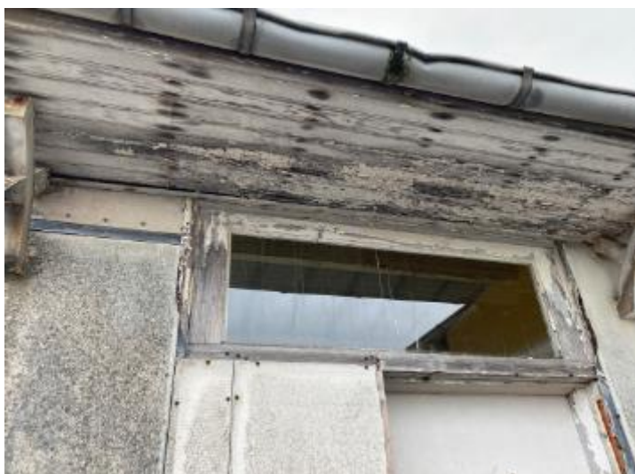
Vue portes et chassis avec toiture et joues à remplacer pour la pose des nouvelles menuiseries (totalité des portes et menuiseries du patio extérieur R+3)
