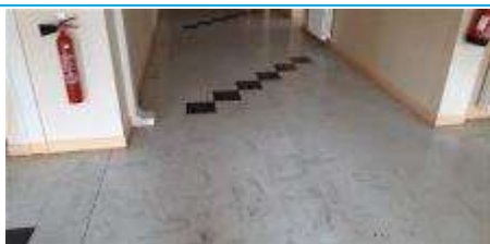
Matériaux : ZPSO-016 Prélèvement : Description : Dalles de sol Localisation : Rez de chaussée - Dégagement 1 Résultat : Présence d'amiante Quantité :
