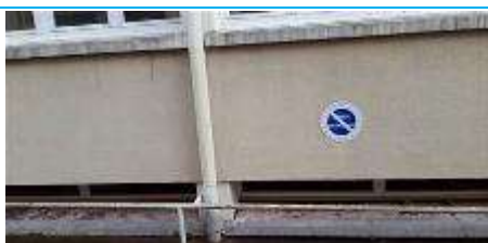
Matériaux : ZPSO-122 Prélèvement : Description : Conduits Localisation : Extérieur - Bâtiment Résultat : Présence d'amiante Quantité :
