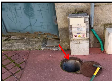
Photo 13 : Départ inspection par la boîte de branchement B.B.
