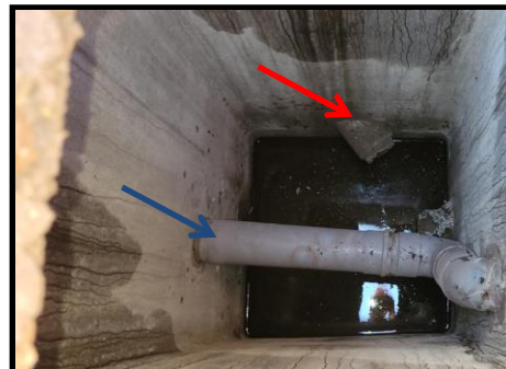
Photo 6 : A \sim 1.50 m du départ inspection – arrivée dans le regard R3.2 – stagnation d'eau dans le fond de regard et constat du PVC traversant venant de Amont R3.1 vers R3.1
