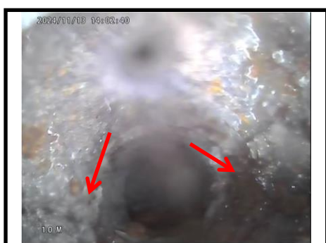
Photo 1 : A \sim 1 m du départ inspection – vue de l'état de vétusté de la fonte.
