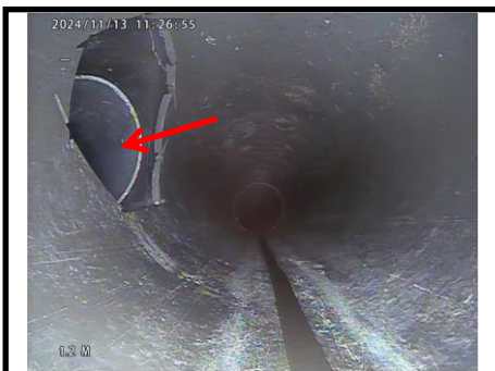
Photo 8 : A \sim 1.50 m du départ inspection – Arrivée sur Brt 1 – Branchement indéterminé.
