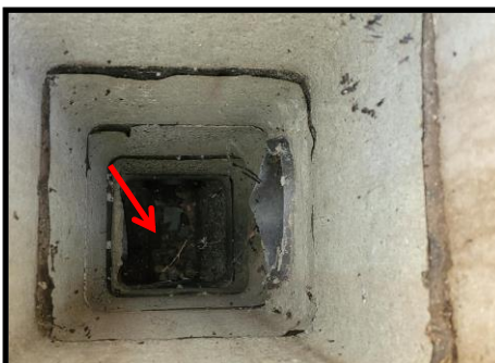
Photo 14 : Départ inspection par la boîte de branchement B.B – constat de gravats dans le fond de regard.
