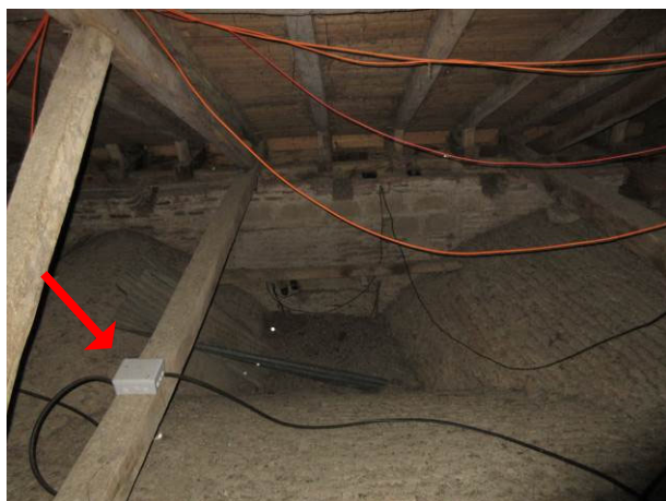
6. Présence d'une boîte de dérivation fixée sur l'entrait en bois de la ferme. Encrassement en partie basse des reins de voûte.
