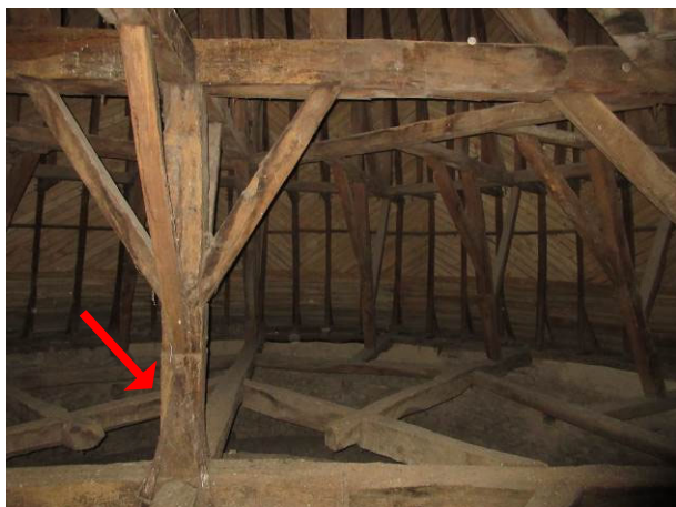
8. Renfort métallique au droit du poinçon. Absence de réseau d'éclairage dans les combles.
