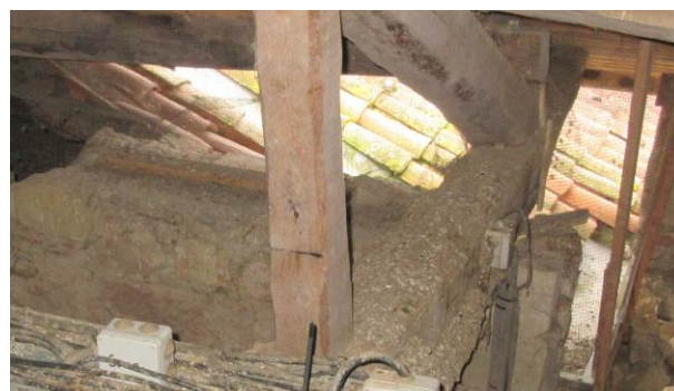
4. Ouverture vers extérieur en bas de pente avec protection grillagée vers bas-côté Sud.
