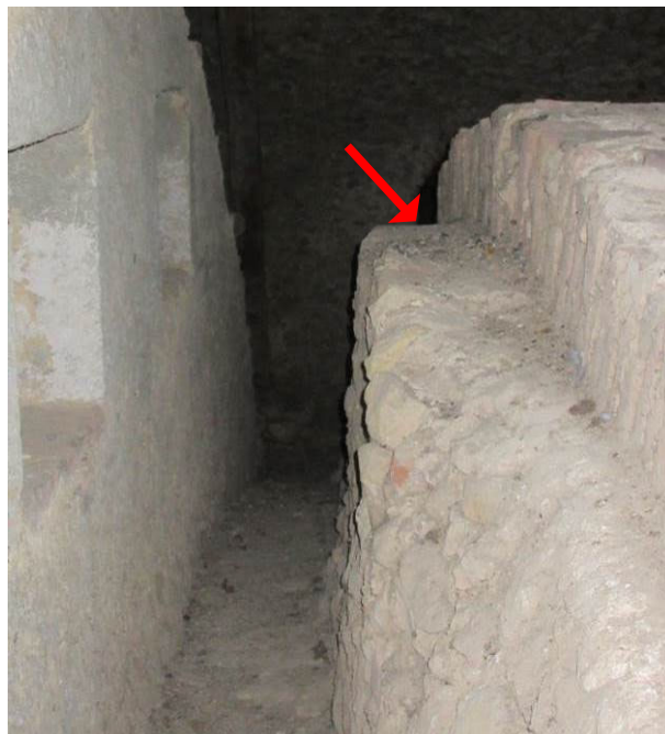
12. Passage sur arc (entre croisée et chœur). Présence de fientes sur les maçonneries de la voûte.
