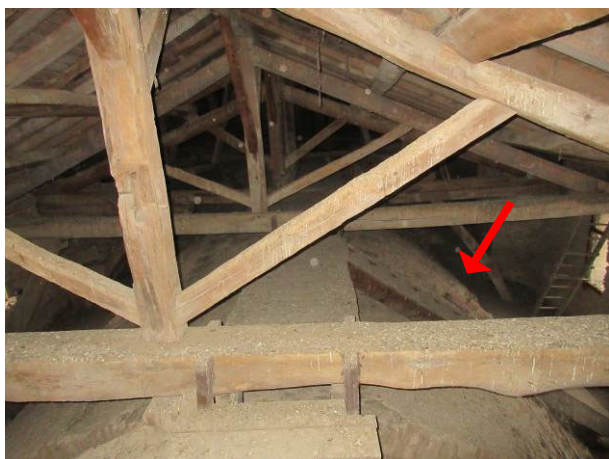
16. Vue vers le chœur. Absence de protection au vide au droit du passage de visite et de l'escalier d'accès à la passerelle. Absence de lumière dans l'ensemble des combles. Photos Atelier d'Architecture R. Duplat du 22 janvier 2020.
