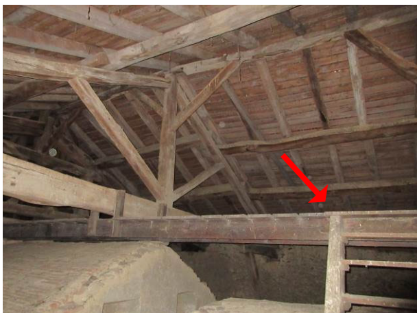
11. Absence de protection au vide au droit du passage de visite et de l'escalier d'accès à la passerelle.
