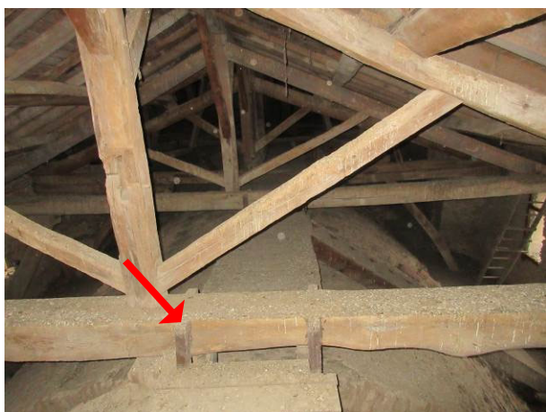
18. Plafage de visite suspendu aux entrails par des rajouts en bois. Absence de protection au vide.
