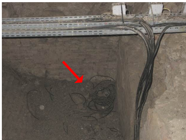
19. Présence de câbles électriques en bas de reins de voûte. Oxydation des chemins de câbles. Photo Atelier d'Architecture R. Duplat du 22 janvier 2020.
