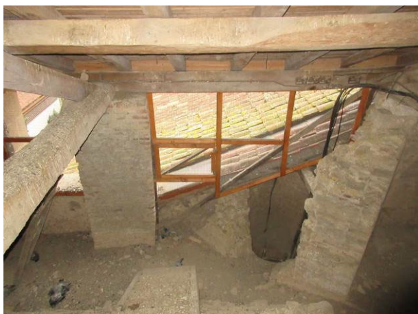
1. Présence d'ouvertures dans les combles avec panneaux grillagés sur bâtis bois. Ensemble des photos Atelier d'Architecture R. Duplat du 22 janvier 2020. Palier d'arrivée de l'ancien escalier.
