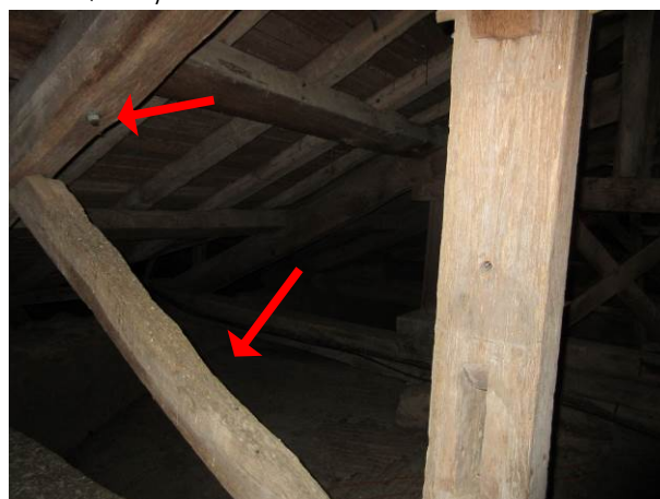
6. Altération de la contrefiche. Renforcement de la charpente par tire-fond.
