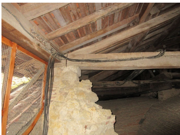
3. Remontée des câbles par le fût de l'ancien escalier.
