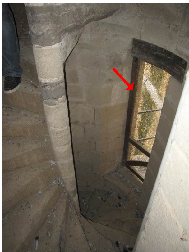
15. Baie ouverte entre escalier et passerelle de liaison avec protection grillagée sur bâti bois permettant les courants d'air entre les différents combles.
