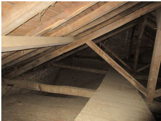
1. Absence de garde-corps pour protection au vide sur le platelage de visite. Photos Atelier d'Architecture R. Duplat du 22 janvier 2020.
