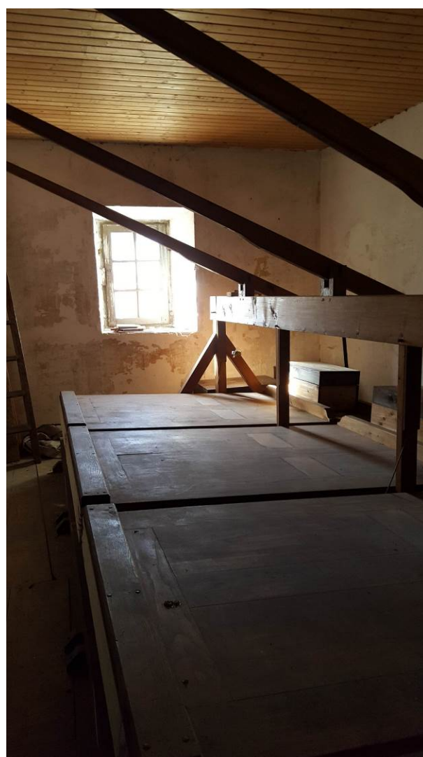
5. Salle du soufflet de l'orgue. Coupe-feu difficile à réaliser compte-tenu de l'échange d'air nécessaire avec l'orgue situé dans le volume voisin.
