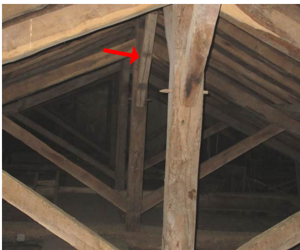
2. Vue d'ensemble des combles vers Ouest. Contrefiche fendue.
