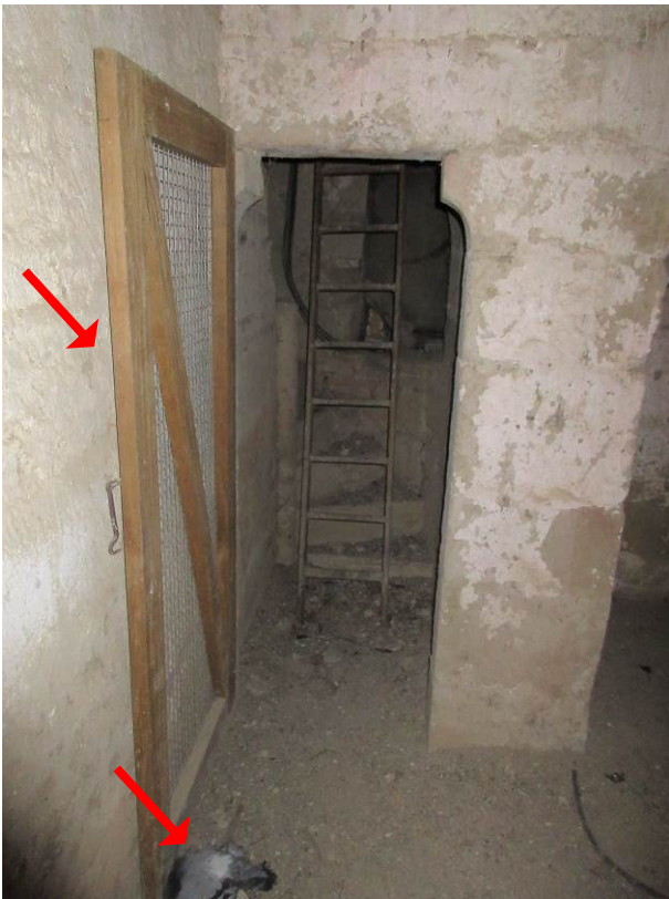
24. Porte avec protection grillagée ne permettant pas d'isoler la salle 2 des combles hauts. Présence de cadavres de pigeon. Photos Atelier d'Architecture R. Duplat du 22 janvier 2020.
