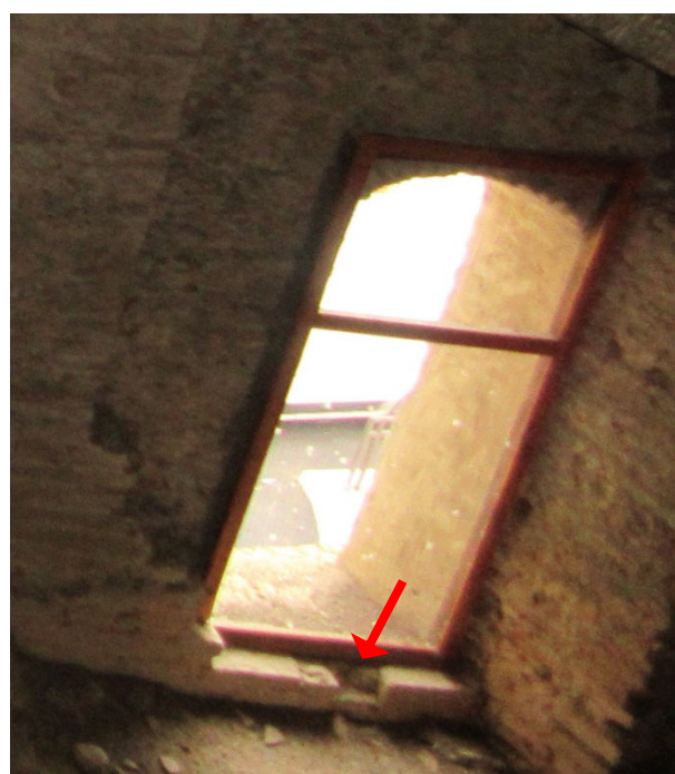
26. Pierre d'appui cassée. Baie ouverte à l'air libre avec protection grillagées sur bâti bois. Photos Atelier d'Architecture R. Duplat du 22 janvier 2020.
