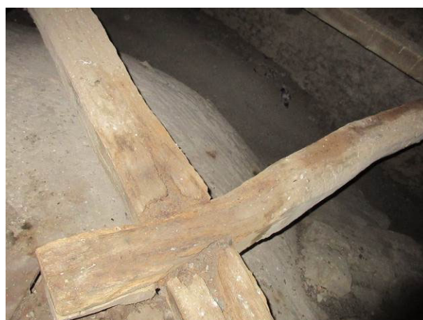
12. Pourrissement partiel d'une liaison.
