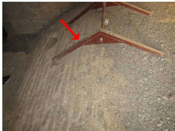
18. Support métallique du lustre suspendu dans chapelle des Saintes Reliques. Encrassement des sols. Photos Atelier d'Architecture R. Duplat du 22 janvier 2020.
