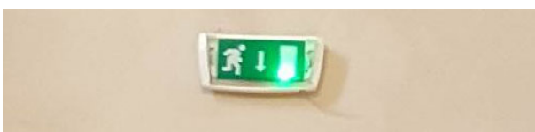
3. Détail pictogramme bloc autonome de sécurité.
