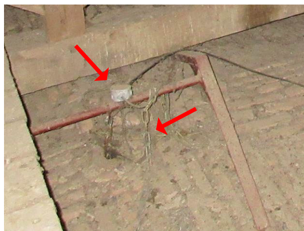
7. Boîte de dérivation à bout d'usage pour l'alimentation du lustre du bras de transept Sud. Équerre et chaîne de suspension du lustre oxydées.
