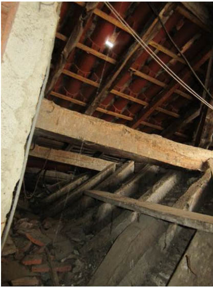
9 et 10. Accès aux combles par la Mairie. Présence de gravats (débris de tuiles, etc.). Présence de câbles aériens suspendus à la charpente. Photos Atelier d'Architecture R. Duplat du 22 janvier 2020.
