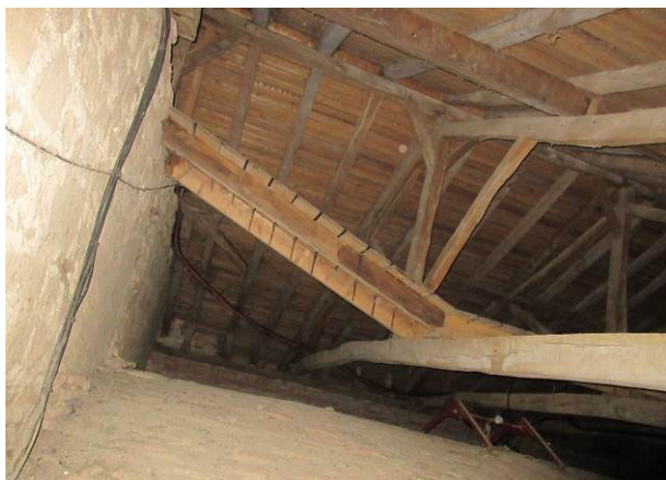
27. Passerelle inclinée sans garde-corps.
