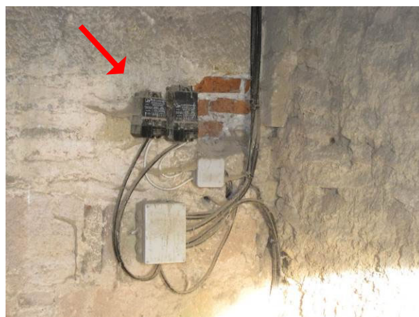
20. Altération et vieillissement du réseau électrique.
