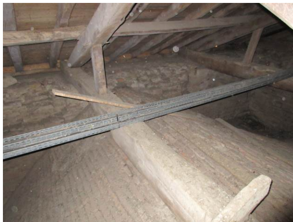
14. Encrassement des arases. Présence de poussière sur les reins de voûtes en briques.
