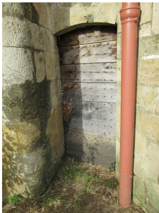
20. Altération de la porte de 90 cm x 204 cm de hauteur. Encombrement du sol. Photos Atelier d'Architecture R. Duplat du 22 janvier 2020.
