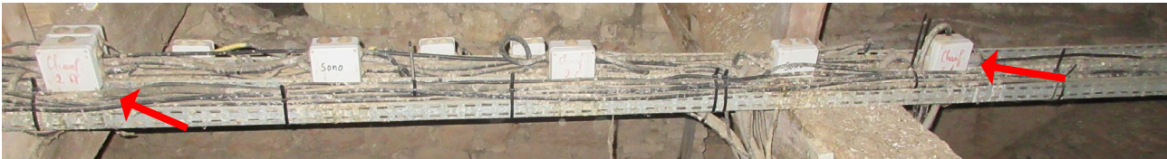
8. Encrassement important du chemin de câbles (fientes, poussière, etc.). Présence d'inscription sur les boîtiers de dérivation (chauffage, sono, etc.).
