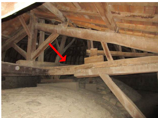
6. Affaiblissement ponctuel de l'entrait (trait de Jupiter). Photos Atelier d'Architecture R. Duplat du 22 janvier 2020.
