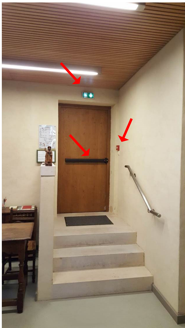
8. Issue de secours existante avec bloc autonome de sécurité, boîtier d'alarme et barre antipanique.
