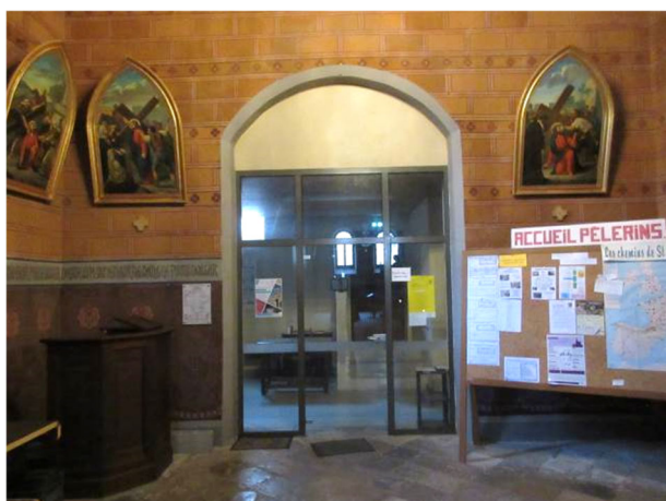
11. Ensemble vitré, accès sacristie. 1 unité de passage lorsque la porte vitrée est ouverte. Photos Atelier d'Architecture R. Duplat du 22 janvier 2020.
