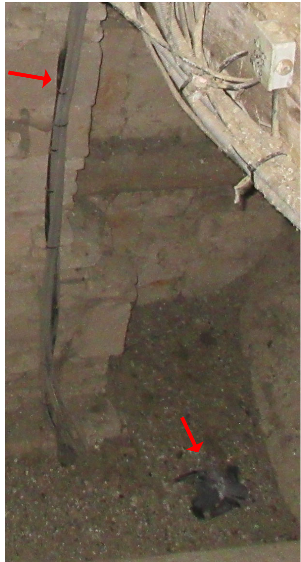
10. Cheminement intérieur du ruban du paratonnerre. Présence de nombreux cadavres de pigeons.
