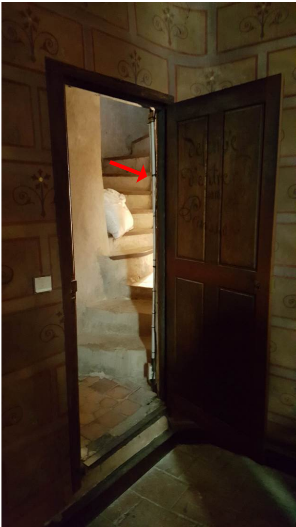
1. Accès à la tribune à partir de l'escalier. Cheminement fourreau électrique fixé par des colliers sur le bâti bois de la porte.
