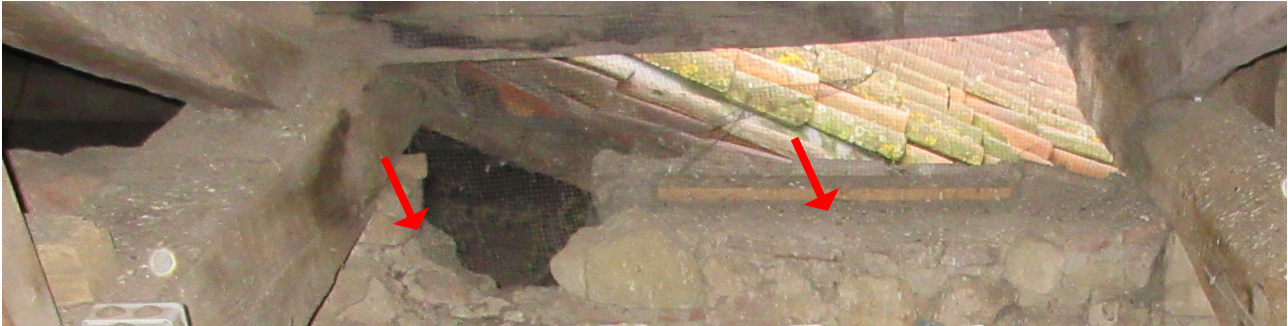
7. Altération de l'arase entre le vaisseau principal et le transept Sud. Grillage de protection à bout d'usage.
