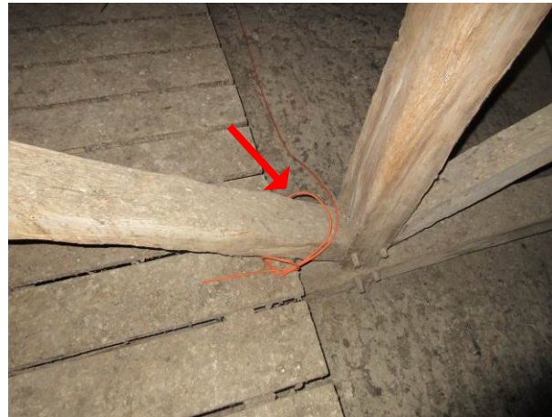
5. Câble électrique en contact le bois de la contre-fiche de la ferme.
