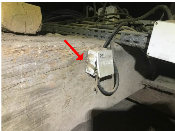
1. Boîte de dérivation électrique ouverte. Photo transmise le 20 mai 2019 par l'entreprise TMH.
