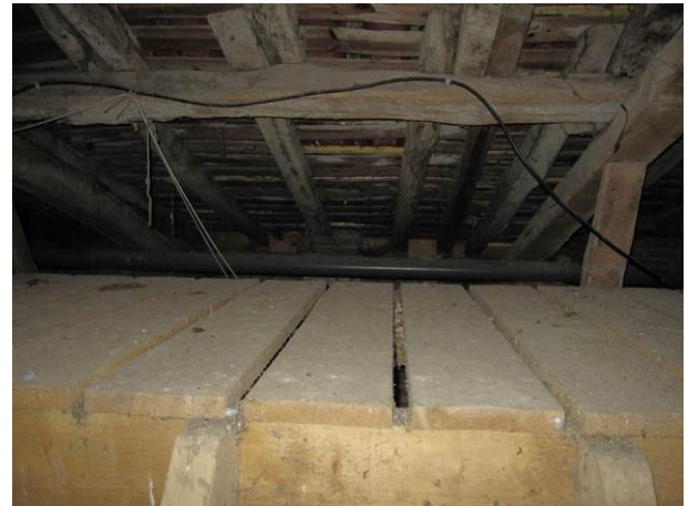
13. Platelage de circulation dans les combles. Câble électrique suspendu à la panne.
