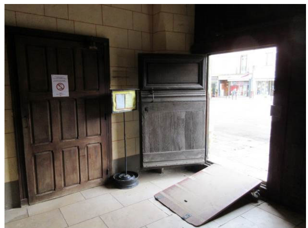
5. Porte latérale intérieure Sud de 115 cm x 222 cm de hauteur avec ferme-porte. Marche intérieure de 23 cm de hauteur. Présence d'une rampe en bois amovible (pente hors norme).
