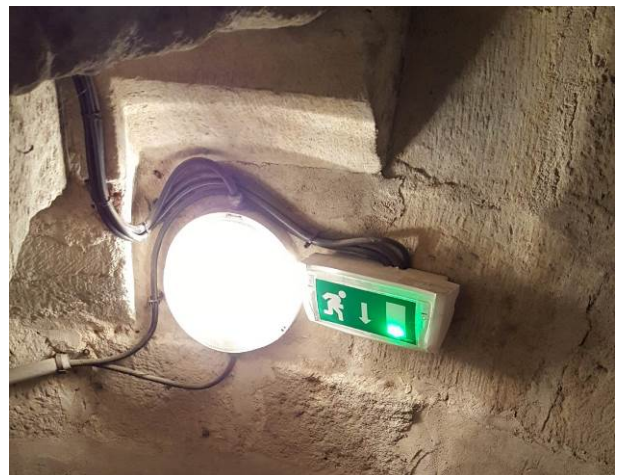
3. Hublot d'éclairage et bloc autonome de sécurité situés dans la cage d'escalier. Cheminement aléatoire de câbles électriques. Photos Atelier d'Architecture R. Duplat du 20 février 2020.
