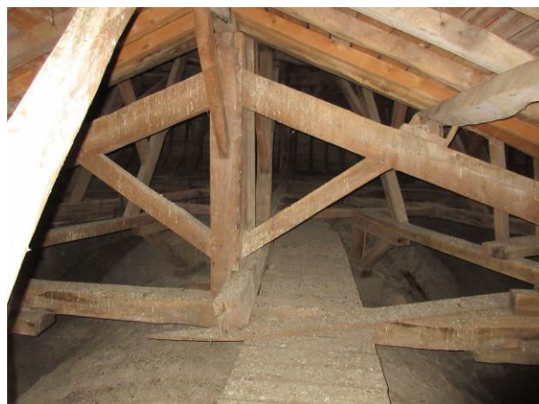
7. Encrassement des bois par la présence de fientes. Absence de garde-corps sur le platelage de visite.
