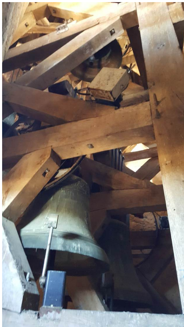
8. Encrassement des cloches et du beffroi en bois (fientes de pigeons). Photos Atelier d'Architecture R. Duplat du 20 février 2020.
