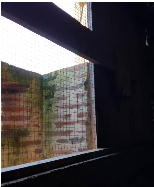
7. Altération des encadrements en bois et du grillage anti-volatiles.
