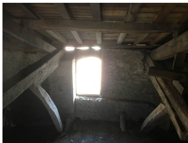
15. Baie ouverte avec protection grillagée, favorisant les courants d'air dans les combles mais sans protection de l'appui.
