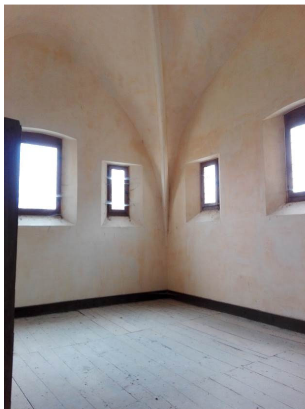
2. Réouverture des baies sur les 3 façades, réalisée en 1999.
