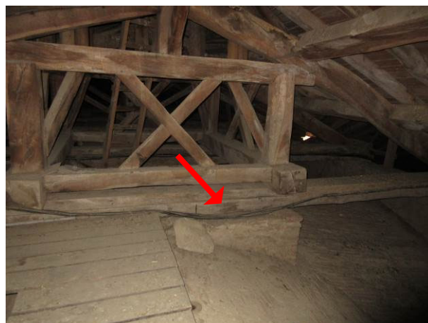
14. Cheminement intempestif de câbles électriques.
