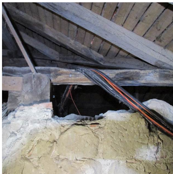
4. Câbles électriques au contact des bois de la charpente (entrait de ferme). Photo transmise le 20 mai 2019 par l'entreprise TMH.
