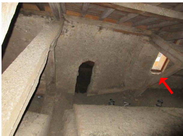
16. Encrassement des bois. Altération de l'appui de baie. Photos Atelier d'Architecture R. Duplat du 22 janvier 2020.
