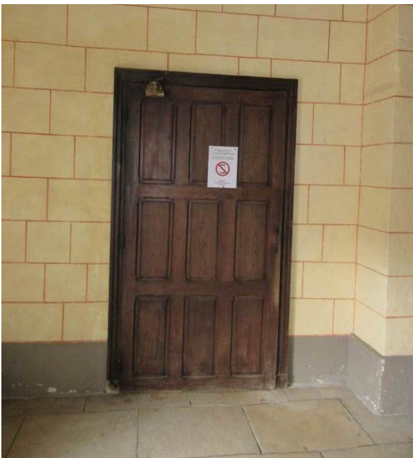
3. Porte latérale intérieure Nord de 115 cm x 222 cm de hauteur avec ferme-porte.
