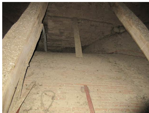
5. Encrassement généralisé (charpente, reins de voûtes, etc.).
