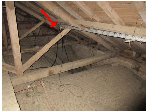
2. Absence de continuité du chemin de câble. Circulation anarchique des câbles électriques.
