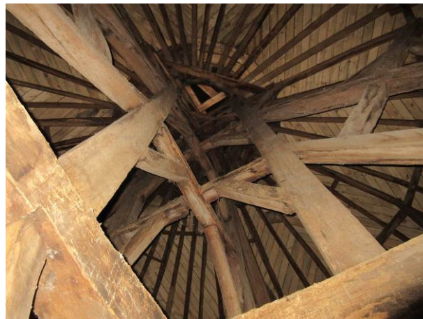
9. Etat correct de la charpente et de la sous-face du voligeage de la coupole.
