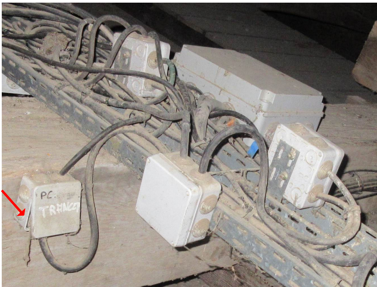
22. Encrassement généralisé des chemins de câbles des boîtiers, des boîtes de dérivation, des câbles électriques. Boîte de dérivation PC ouverte. Pas de renseignement, ni de plan sur les différentes alimentations électriques. Photos Atelier d'Architecture R. Duplat du 22 janvier 2020.
