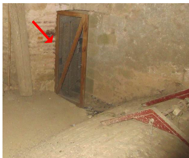
17. Protection grillagée sur bâti bois, côté salle 1.
