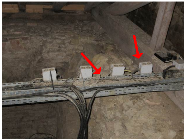
18. Présence importante de fientes de pigeons sur les chemins de câbles, les câbles de distribution, les boîtes de dérivation, etc.
