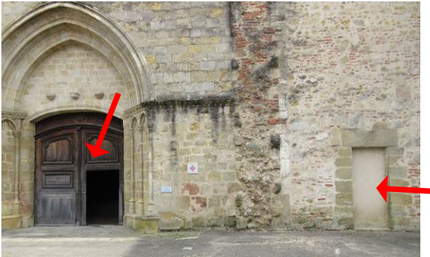
1. Porte double 314 cm x 330 cm (5 unités de passage). 1 porte ouverte la journée 107 cm x 190 cm. Marche intérieure 23 cm de haut. Porte obturée de 100 cm x 215 cm de hauteur avec ressaut de 6 cm (revers des fonts baptismaux). Photos Atelier d'Architecture R. Duplat du 22 janvier 2020.
