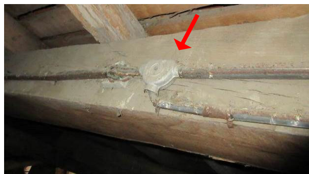
23. Ancien cheminement du réseau électrique dans des fourreaux métalliques (ensemble à bout d'usage).
