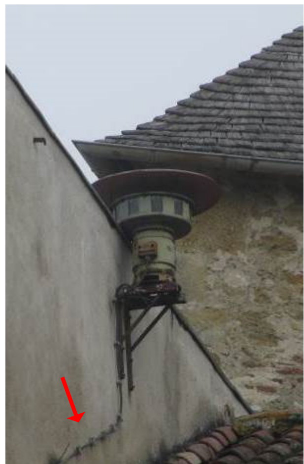
27. Cheminement de l'alimentation par câble de la sirène. Oxydation des parties métalliques
