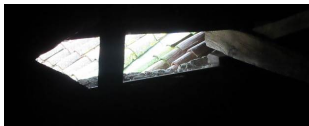
3. Ouverture vers extérieur en bas de pente avec protection grillagée vers bas-côté Nord.
