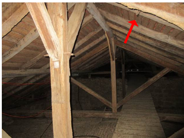
8. Encrassement de la charpente et du voligeage. Présence de clous oxydés (sans doute pour fixer d'anciens câbles ?). Photos Atelier d'Architecture R. Duplat du 22 janvier 2020.
