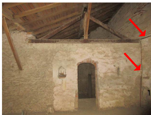
23. Partie ouverte au-dessus du refend et absence de porte. Cheminement aléatoire de câbles électriques. Photos Atelier d'Architecture R. Duplat du 22 janvier 2020.
