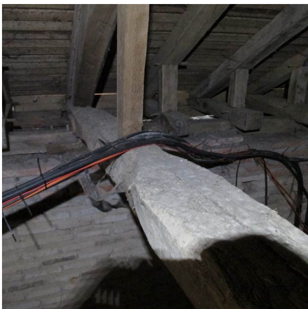
3. Circulation anarchique des câbles électriques au contact des bois de la charpente. Photo transmise le 20 mai 2019 par l'entreprise TMH.
