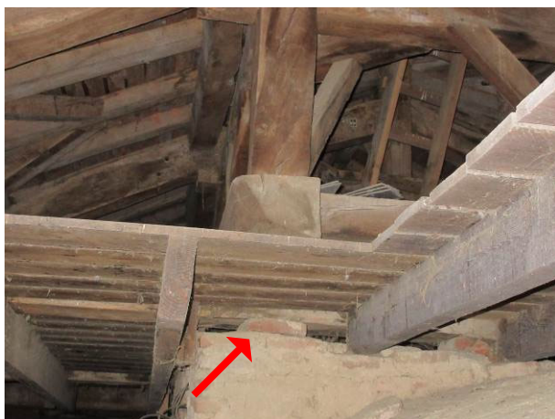
13. Calle posée sur la voûte de la croisée. Photos Atelier d'Architecture R. Duplat du 22 janvier 2020.
