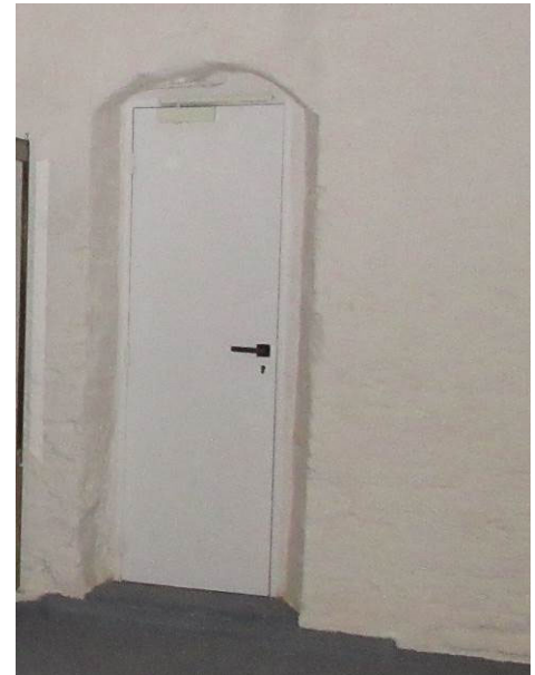
7. Accès aux combles. Porte coupe-feu 1 heure avec ferme-porte.
