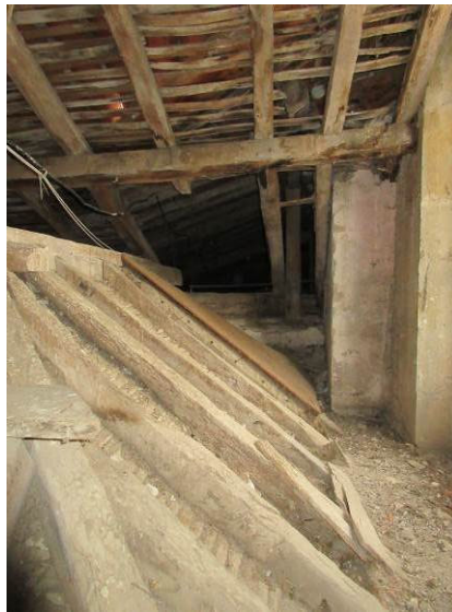
9 et 10. Accès aux combles par la Mairie. Présence de gravats (débris de tuiles, etc.). Présence de câbles aériens suspendus à la charpente. Photos Atelier d'Architecture R. Duplat du 22 janvier 2020.
