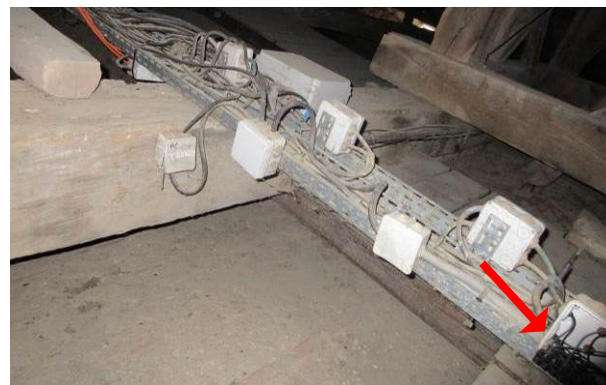
20. Boîte de dérivation électrique ouverte.
