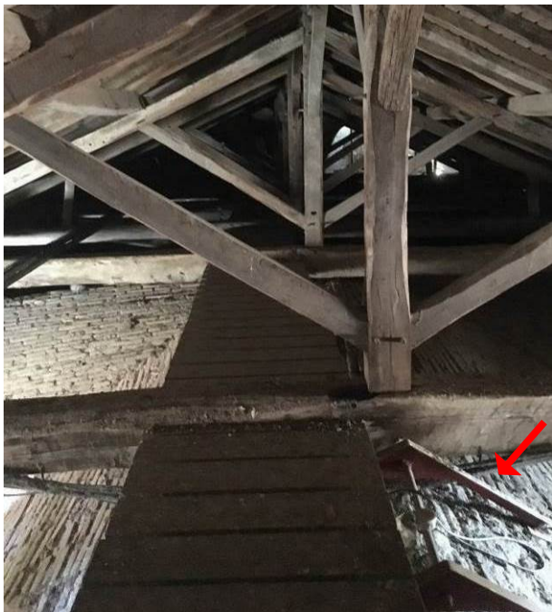
15. Support métallique oxydé du lustre. Présence de lumière naturelle dû aux ouvertures laissées libres. Photo Atelier d'Architecture R. Duplat du 16 mai 2019.
