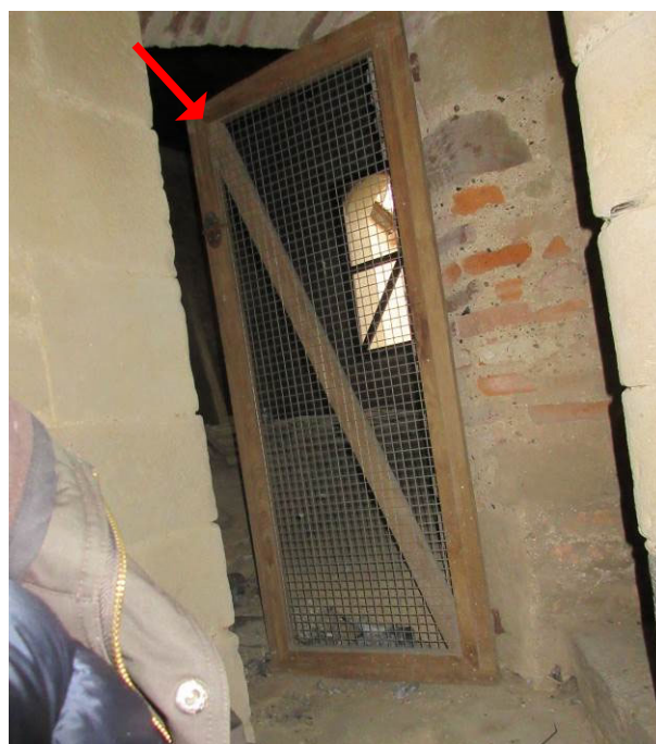
16. Protection grillagée sur bâti bois, côté escalier.
