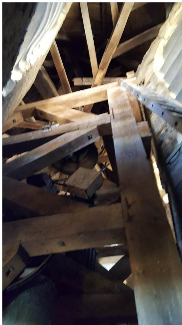
12. État passable des charpentes du clocher.
