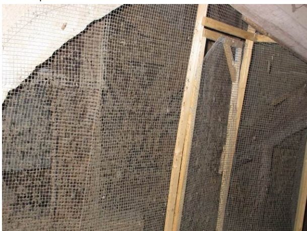
22. Empoussièrément et encrassement de la cloison en grillage anti-volatiles. Section des bâtis bois très faible. Photo Atelier d'Architecture R. Duplat du 22 janvier 2020.
