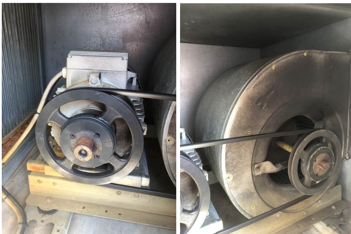
Ensemble moteur et ventilateur de reprise – Vieillessement constaté
