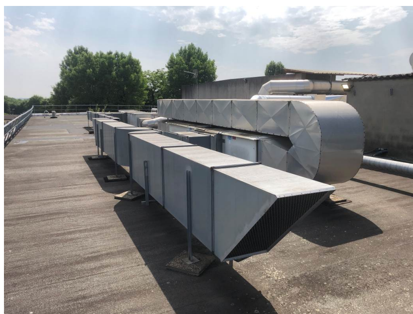
Prises d'air neuf et rejet de la CTA
