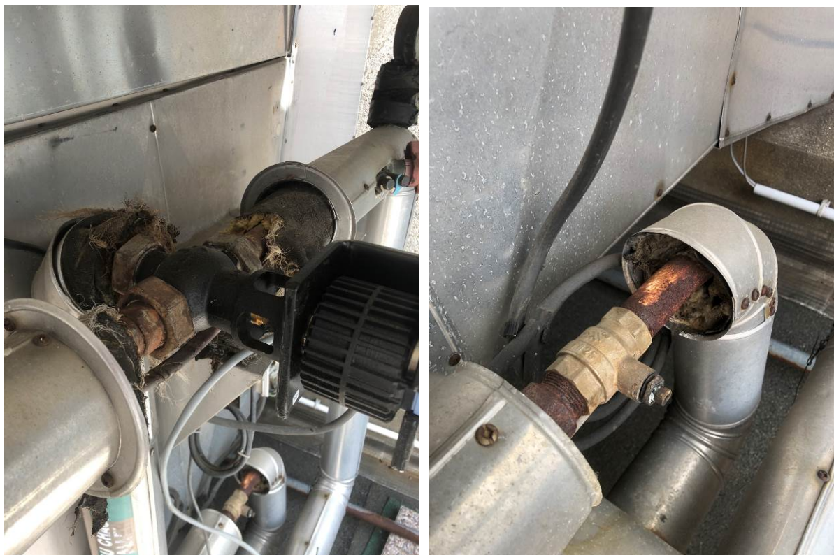
Dégradation/corrosion de la vanne 3 voies et des tuyauteries eau chaude
