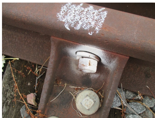
Boulon non conforme
