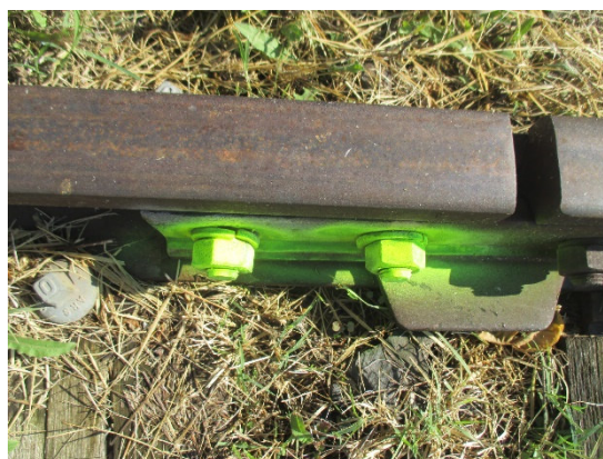
Boulon non conforme
