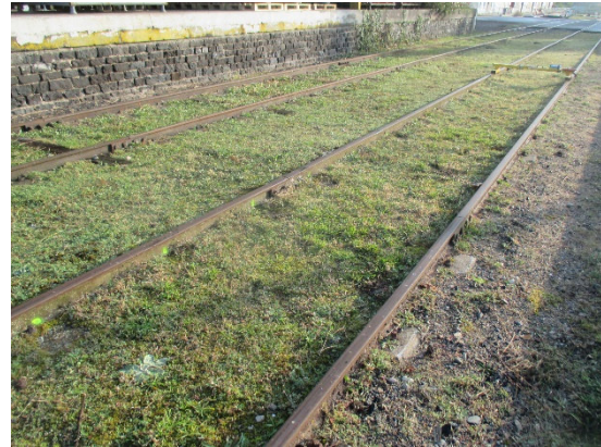
Traverses a remplacer pour maintien du rail
