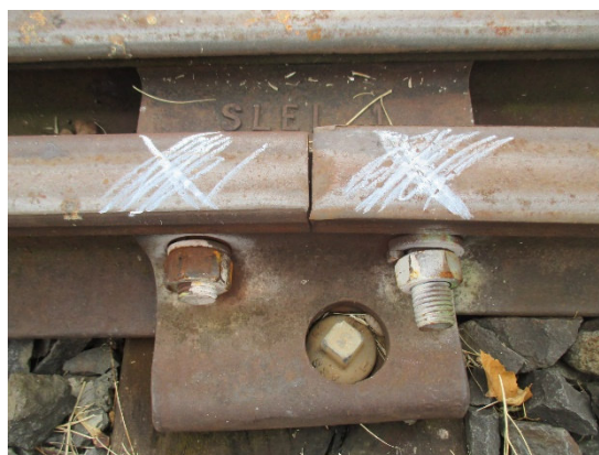
Boulon non conforme
