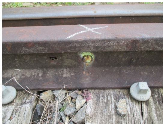
Boulon non conforme
