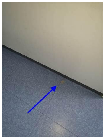
Photo n° PhA010 Localisation : 1er étage - Refectoire 12 Ouvrage : 5 - Planchers et planchers techniques - Revêtements de sols Partie d'ouvrage : Linoléum + colle + ragréage Description : Matériau souple de type revêtement de sol (bleu)
