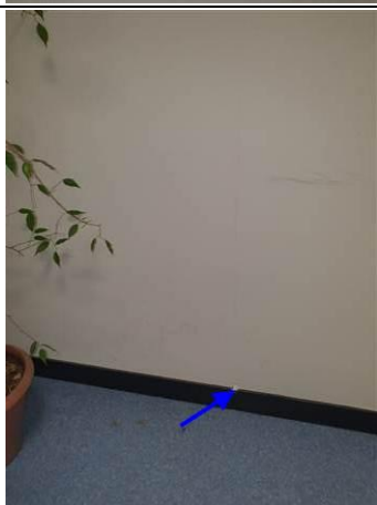
Photo n° PhA009 Localisation : 1er étage - Salle de travail 11 Ouvrage : 3 - Parois verticales intérieures - Murs et cloisons maçonnés Partie d'ouvrage : Papier peint + colle + enduit + peinture Description : Matériau de type maillage de fibres et liant (blanc) ; matériau de type peinture (noir) ; matériau souple fibreux de type papier, carton (marron)
