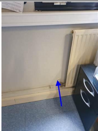
Photo n° PhA007 Localisation : 1er étage - Salle de travail 11 Ouvrage : 3 - Parois verticales intérieures - Murs et cloisons maçonnés Partie d'ouvrage : Papier peint + colle + enduit + peinture Description : Matériau fibreux de type papier peint (gris)
