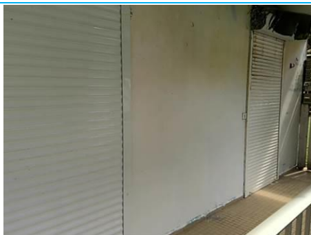
Matériaux : Z04-Ensemble des murs balcon- Enduit de mur avec peinture Prélèvement : P009 Description : enduit + peinture Localisation : BAT 2 - Façade ouest - RDC mur balcon Résultat : Présence d'amiante
