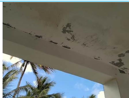
Matériaux : Z02 - Ensemble du bâtiment - Poutre du balcon - enduit + peinture Prélèvement : P002 Description : enduit + peinture Localisation : BAT 2 - Façade ouest - Poutre balcon Résultat : Absence d'amiante
