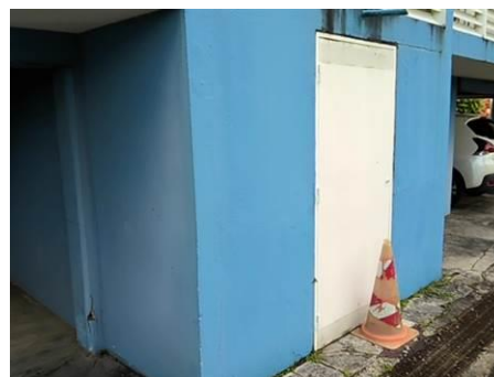
Matériaux : Z18 - Façades extérieures - Mur - enduit + peinture Prélèvement : P033 Description : enduit + peinture Localisation : Bâtiment 001 - Façades extérieures - Est - Mur Résultat : Absence d'amiante
