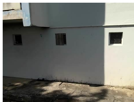
Matériaux : Z18 - Façades extérieures - Mur - enduit + peinture Prélèvement : P035 Description : enduit + peinture Localisation : Bâtiment 001 - Façades extérieures - Ouest Résultat : Absence d'amiante
