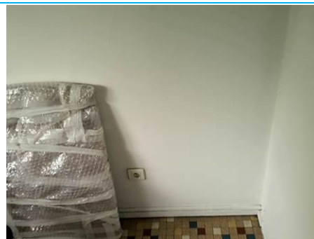
Matériaux : Z09 - Ensemble Bâtiment - Séjour, Dégagement, Chambres - Mur - enduit + peinture Prélèvement : P029 Description : enduit + peinture Localisation : Bâtiment 001 - Logement 003 - Chambre 1 Résultat : Présence d'amiante
