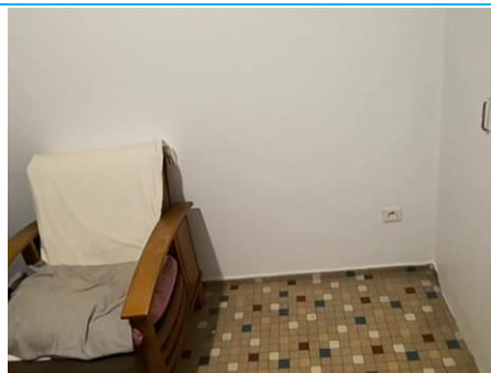
Matériaux : Z09 - Ensemble Bâtiment - Séjour, Dégagement, Chambres - Mur - enduit + peinture Prélèvement : P017 Description : enduit + peinture Localisation : Bâtiment 001 - Logement 002 - Chambre 3 Résultat : Présence d'amiante
