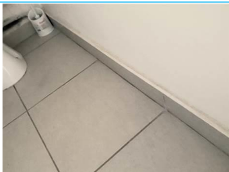
Matériaux : Z07 - Ensemble Bâtiment - Salle de bain, WC - Plinthe 45x10 - Colle de Plinthe Prélèvement : P009 Description : colle de plinthe Localisation : Bâtiment 001 - Logement 001 - WC Résultat : Absence d'amiante
