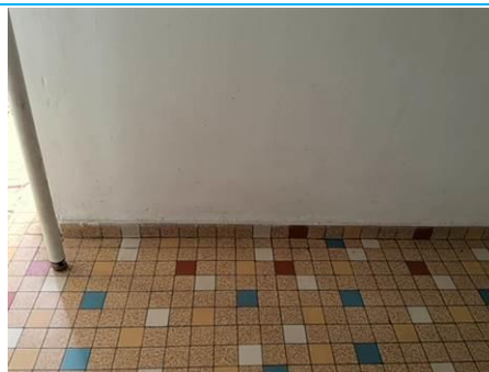
Matériaux : Z04 - Ensemble Bâtiment - Cuisine - Plinthe 5x5 - Colle de plinthe Prélèvement : P004 Description : colle de plinthe Localisation : Bâtiment 001 - Logement 001 - Cuisine Résultat : Absence d'amiante
