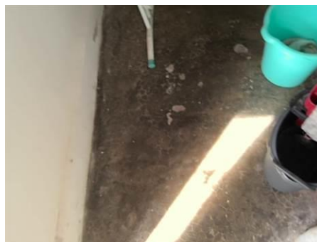
Matériaux : Z14 - Ensemble Bâtiment - Cellier - Sol - Chappe Prélèvement : P006 Description : chappe Localisation : Bâtiment 001 - Logement 001 - Cellier Résultat : Absence d'amiante
