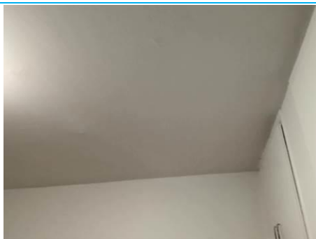
Matériaux : Z08 - Ensemble Bâtiment - Séjour, Dégagement, Chambres - Plafond - enduit + peinture Prélèvement : P018 Description : enduit + peinture Localisation : Bâtiment 001 - Logement 002 - Chambre 3 Résultat : Présence d'amiante
