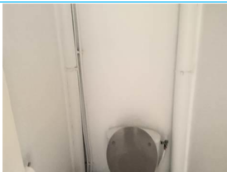
Matériaux : Z01 - Ensemble Bâtiment - Cuisine, Salle d'eau, WC - Mur - Peinture + enduit Prélèvement : P007 Description : enduit + peinture Localisation : Bâtiment 001 - Logement 001 - WC Résultat : Présence d'amiante
