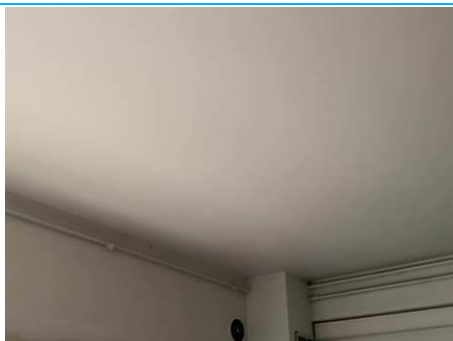
Matériaux : Z02 - Ensemble Bâtiment - Cuisine, Salle d'eau, WC - Plafond - Peinture + enduit Prélèvement : P022 Description : enduit + peinture Localisation : Bâtiment 001 - Logement 003 - Plafond Résultat : Présence d'amiante
