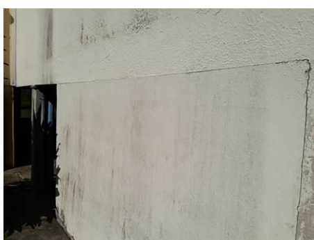
Matériaux : Z18 - Façades extérieures - Mur - enduit + peinture Prélèvement : P036 Description : enduit + peinture Localisation : Bâtiment 001 - Façades extérieures - Nord - Mur Résultat : Absence d'amiante
