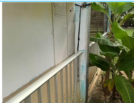
Matériaux : Z03-Ensemble des poteaux - Enduit de poteau avec peinture Prélèvement : P008 Description : enduit + peinture Localisation : BAT 2 - Façade ouest - RDC poteau balcon Résultat : Présence d'amiante
