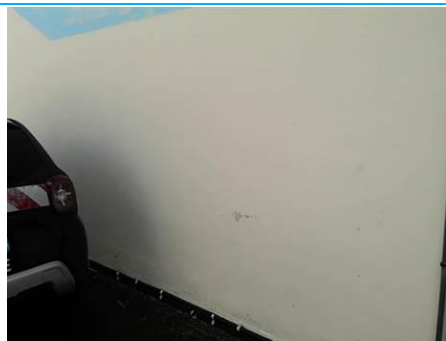
Matériaux : Z06-Ensemble des murs pignons- Enduit de mur avec peinture Prélèvement : P010 Description : enduit + peinture Localisation : BAT 2 - Façade sud - mur blanc Résultat : Absence d'amiante
