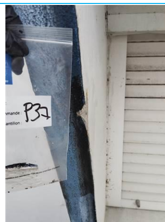
Matériaux : Z26 - Façades extérieures - Embrasure fenêtre - enduit + peinture Prélèvement : P037 Description : enduit + peinture Localisation : Bâtiment 001 - Façades extérieures - Est - Embrasure Résultat : Absence d'amiante
