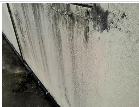
Matériaux : Z04-Ensemble des murs balcon- Enduit de mur avec peinture Prélèvement : P012 Description : enduit + peinture Localisation : BAT 2 - Façade est - Mur Résultat : Présence d'amiante
