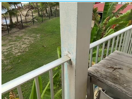
Matériaux : Z03-Ensemble des poteaux - Enduit de poteau avec peinture Prélèvement : P003 Description : enduit + peinture Localisation : BAT 2 - Façade ouest - Poteau balcon Résultat : Présence d'amiante
