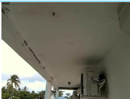
Matériaux : Z01 - Ensemble du bâtiment - Plafond du balcon - enduit + peinture Prélèvement : P001 Description : enduit + peinture Localisation : BAT 2 - Façade ouest - Plafond balcon Résultat : Absence d'amiante
