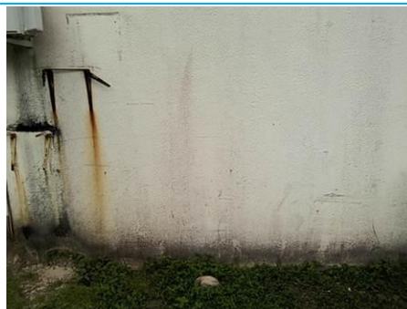
Matériaux : Z06-Ensemble des murs pignons- Enduit de mur avec peinture Prélèvement : P016 Description : enduit + peinture Localisation : BAT 2 - Façade nord - Mur blanc Résultat : Absence d'amiante
