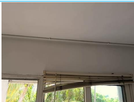
Matériaux : Z01 - Ensemble Bâtiment - Cuisine, Salle d'eau, WC - Mur - Peinture + enduit Prélèvement : P001 Description : enduit + peinture Localisation : Bâtiment 001 - Logement 001 - Cuisine Résultat : Présence d'amiante
