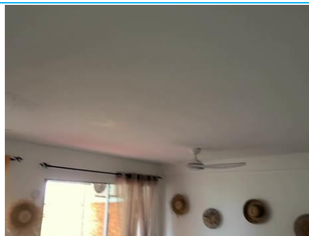
Matériaux : Z08 - Ensemble Bâtiment - Séjour, Dégagement, Chambres - Plafond - enduit + peinture Prélèvement : P013 Description : enduit + peinture Localisation : Bâtiment 001 - Logement 002 - Séjour Résultat : Présence d'amiante
