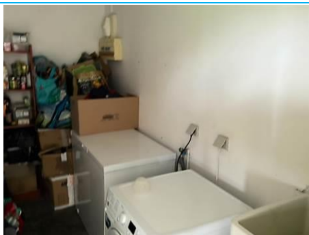
Matériaux : Z13 - Ensemble Bâtiment - Balcon, Loggia, Cellier - Mur - Enduit + peinture Prélèvement : P026 Description : enduit + peinture Localisation : Bâtiment 001 - Logement 003 - Cellier Résultat : Présence d'amiante
