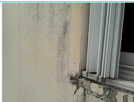
Matériaux : Z09 - Ensemble du bâtiment - Embrasure fenêtre - enduit + peinture Prélèvement : P018 Description : enduit + peinture Localisation : BAT 2 - Façade est - Embrasure fenêtre droite Résultat : Absence d'amiante
