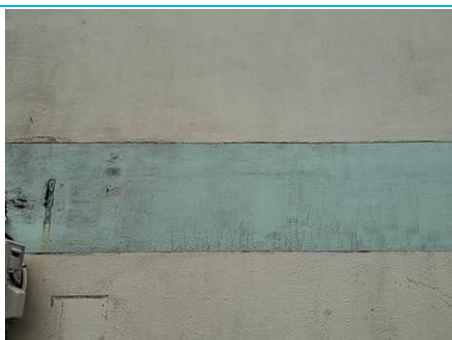
Matériaux : Z06-Ensemble des murs pignons- Enduit de mur avec peinture Prélèvement : P017 Description : enduit + peinture Localisation : BAT 2 - Façade nord - Mur bleu Résultat : Absence d'amiante
