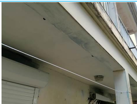
Matériaux : Z02 - Ensemble du bâtiment - Poutre du balcon - enduit + peinture Prélèvement : P007 Description : enduit + peinture Localisation : BAT 2 - Façade ouest - RDC poutre balcon Résultat : Absence d'amiante
