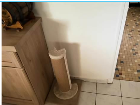
Matériaux : Z09 - Ensemble Bâtiment - Séjour, Dégagement, Chambres - Mur - enduit + peinture Prélèvement : P012 Description : enduit + peinture Localisation : Bâtiment 001 - Logement 002 - Séjour Résultat : Présence d'amiante
