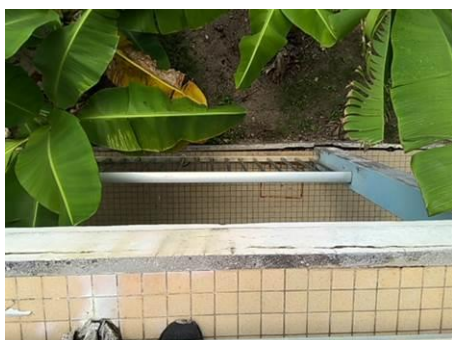
Matériaux : Z05 - Tranche horizontale - enduit + peinture Prélèvement : P005 Description : enduit + peinture Localisation : BAT 2 - Façade ouest - Tranche horizontale Résultat : Absence d'amiante
