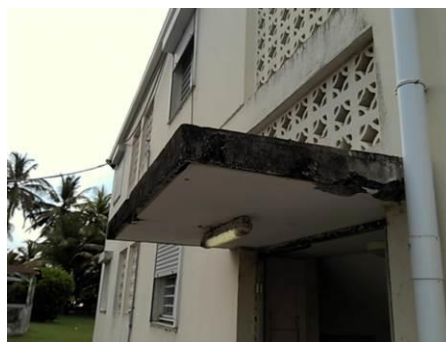
Matériaux : Z08 - Auvent - enduit + peinture Prélèvement : P014 Description : enduit + peinture Localisation : BAT 2 - Façade est - Sous face auvent Résultat : Absence d'amiante
