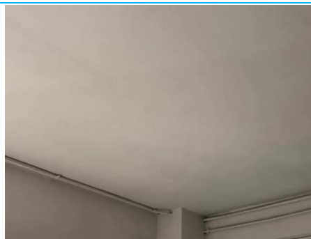
Matériaux : Z02 - Ensemble Bâtiment - Cuisine, Salle d'eau, WC - Plafond - Peinture + enduit Prélèvement : P002 Description : enduit + peinture Localisation : Bâtiment 001 - Logement 001 - Cuisine Résultat : Présence d'amiante
