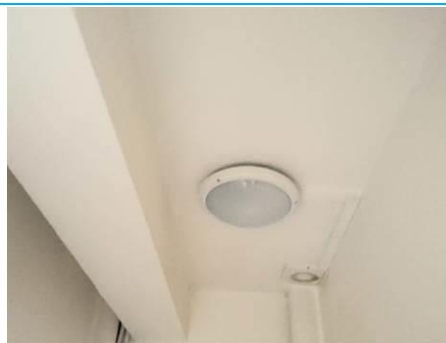
Matériaux : Z02 - Ensemble Bâtiment - Cuisine, Salle d'eau, WC - Plafond - Peinture + enduit Prélèvement : P008 Description : enduit + peinture Localisation : Bâtiment 001 - Logement 001 - WC Résultat : Présence d'amiante
