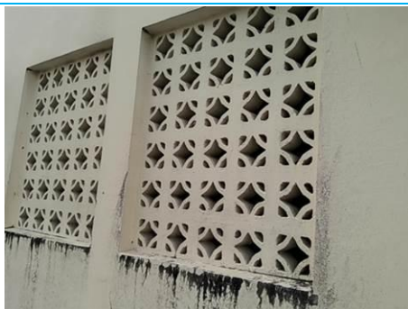
Matériaux : Z07 - Ensemble du bâtiment - élément préfabriqué - enduit + peinture Prélèvement : P013 Description : enduit + peinture Localisation : BAT 2 - Façade est - Element préfabriqué droite Résultat : Absence d'amiante
