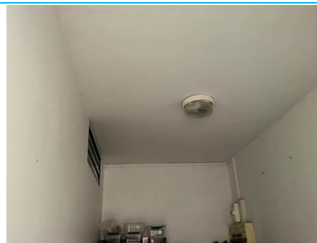
Matériaux : Z12 - Ensemble Bâtiment - Balcon, Loggia, Cellier - Plafond - Enduit + peinture Prélèvement : P027 Description : enduit + peinture Localisation : Bâtiment 001 - Logement 003 - Plafond Résultat : Présence d'amiante
