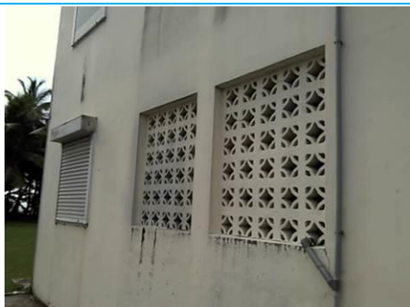
Matériaux : Z07 - Ensemble du bâtiment - élément préfabriqué - enduit + peinture Prélèvement : P015 Description : enduit + peinture Localisation : BAT 2 - Façade est - Elément préfabriqué gauche Résultat : Absence d'amiante
