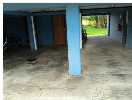
Matériaux : Z19 - Façades extérieures - Poteau - enduit + peinture Prélèvement : P031 Description : enduit + peinture Localisation : Bâtiment 001 - Hall - Poteau Résultat : Absence d'amiante
