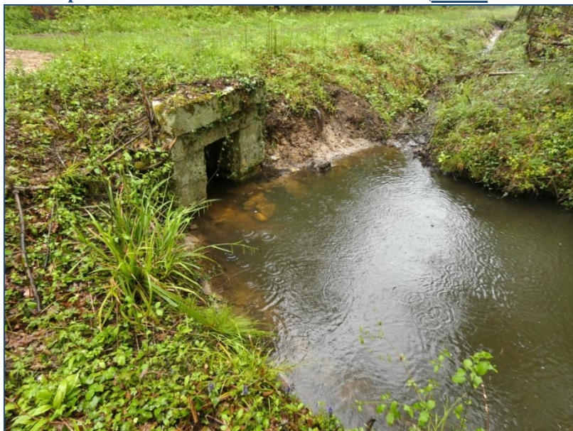
Figure 32 : Fosse et surélargissement du cours d'eau à l'aval de l'ouvrage (Source : SIVY - 05/2023)
