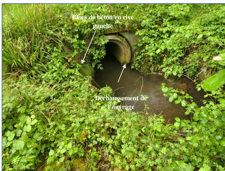
Figure 24 : Déstabilisation du passage busé à l'amont (Source : SIVY - 05/2023)
