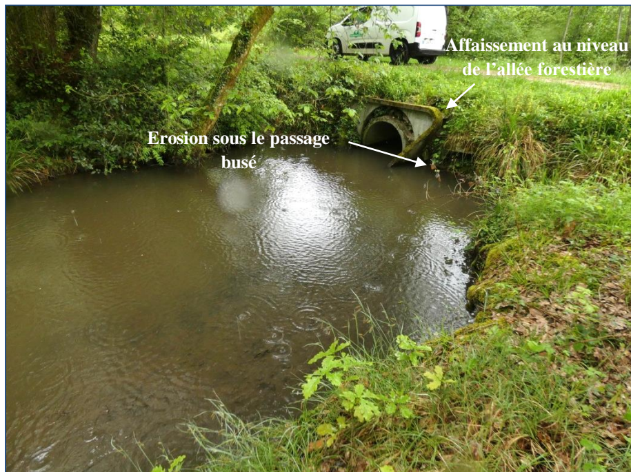
Figure 25 : Erosion à l'aval de l'ouvrage et au niveau de l'allée forestière ( Source : SIVY - 05/2023)
