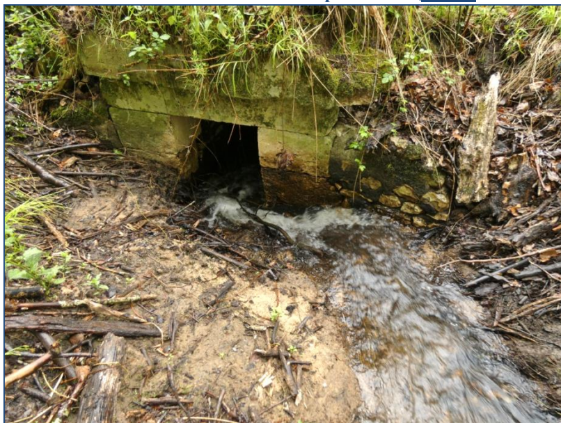
Figure 31 : Le pont cadre est sous-dimensionné et mal calé (Source : SIVY - 05/2023)
