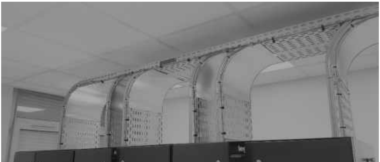
Chemin de câble pour l'entrée dans les baies
