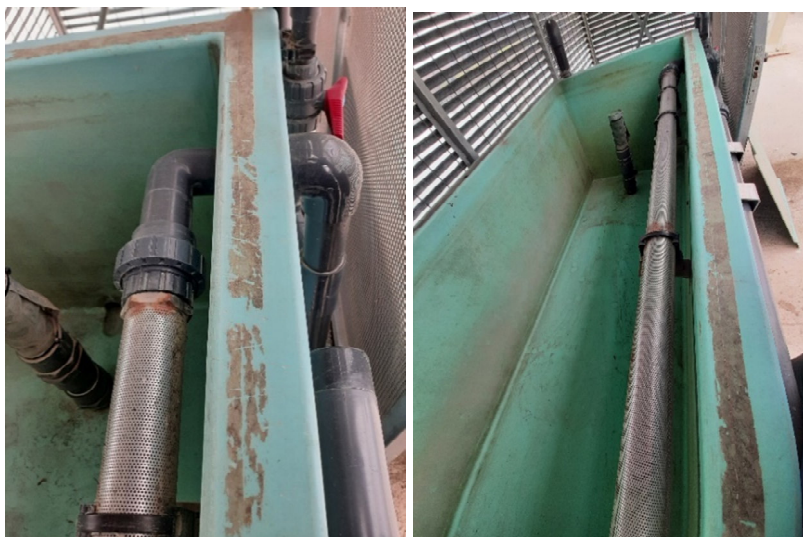
Figure 46. Système de trop-plein utilisé sur le bac de capture/piégeage de la passe à anguilles de Beaucaire sur le Rhône. Photos MRM
