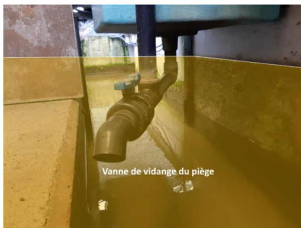
Figure 24. Ennoisement de la vanne de vidange du piège lorsque le canal est mis en charge à la cote de déversement des rampes aval. © SCIMABIO Interface
