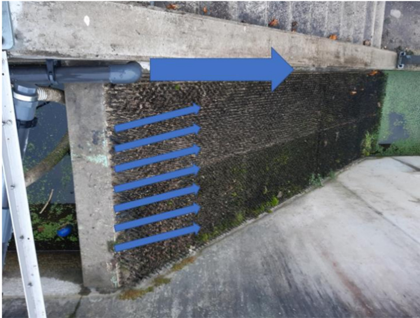
Figure 43. Rampe aval à modifier avec création d'une échancrure en lieu et place du tuyau
