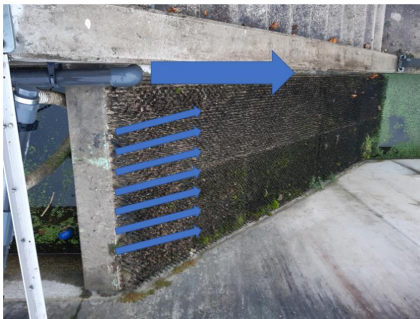
Figure 21. Répartition des débits sur la rampe aval (attrait et aspersion). © SCIMABIO Interface
