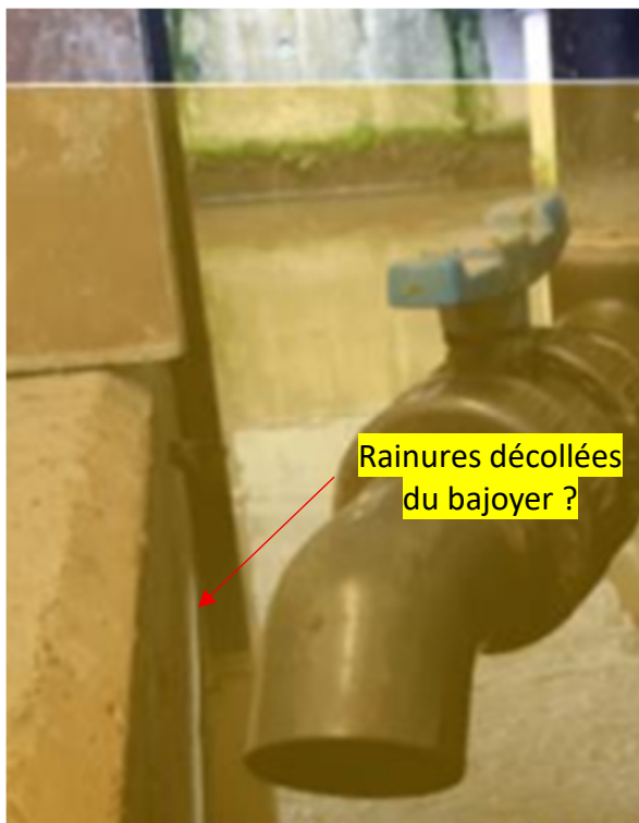
Figure 42. Dysfonctionnement potentiel des rainures
