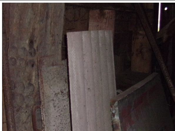
Prélèvement - 1 : Rdc / Garage - Plaque ondulée- (Présence d'amiante)
