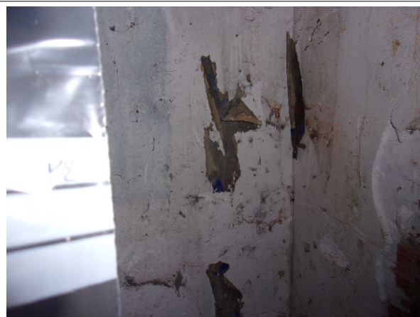
Prélèvement - 2 : Rdc / Local - Enduit- (Absence d'amiante)
