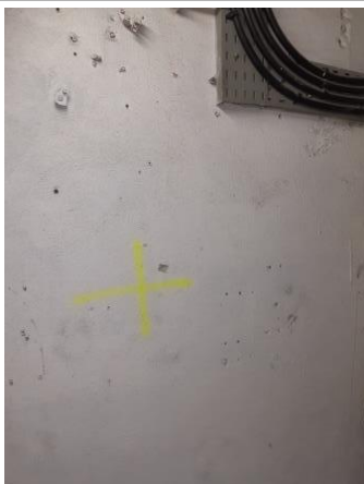
Prélèvement - P001 : Sous sol / Local EDF - Enduit- (Absence d'amiante)
