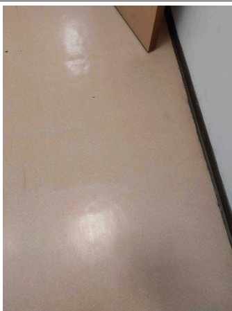
Prélèvement - P007 : R+1 / S 1.44 - Lé plastique avec sous-couche- (Absence d'amiante)
