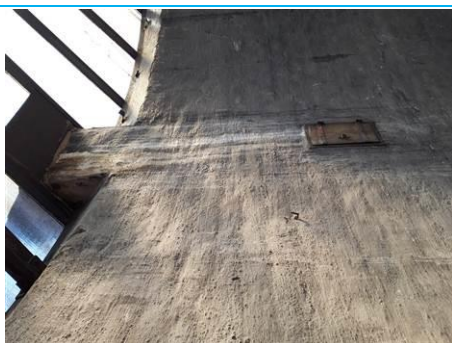
Matériaux : ZPSO-003 Prélèvement : P003 Description : Enduit à base de ciment projeté Localisation : combles - verrière Résultat : Absence d'amiante Quantité :
