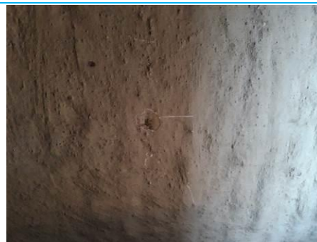
Matériaux : ZPSO-002 Prélèvement : P002 Description : Enduit à base de ciment projeté, peinture Localisation : combles - grenier Résultat : Absence d'amiante Quantité :
