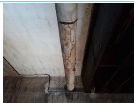
Matériaux : ZPSO-004 Prélèvement : P004 Description : Calorifuge (tresses, coquilles, matelas...) et enveloppe Localisation : combles - réserve Résultat : Absence d'amiante Quantité :
