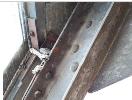
Matériaux : ZPSO-006 Prélèvement : P006 Description : Joint tresse entre menuiserie métallique et verre Localisation : combles - verrière Résultat : Présence d'amiante Quantité : plus de 50 mètre linéaire
