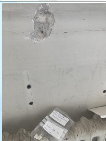
Photo n° PhA027 Localisation : MJA - MJA170 - NIVEAU : 00 - C017 - VACANT Ouvrage : 3 - Parois verticales intérieures - Murs et cloisons maçonnés Partie d'ouvrage : Enduit à base de plâtre lissé ou taloché Description : Enduit + Béton (Mur)
