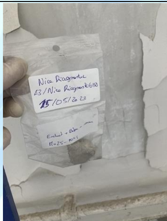
Photo n° PhA025 Localisation : MJA - MJA170 - NIVEAU : 00 - C006-08 - VACANT Ouvrage : 3 - Parois verticales intérieures - Murs et cloisons maçonnés Partie d'ouvrage : Enduit à base de plâtre lissé ou taloché Description : Enduit + Béton (Mur)
