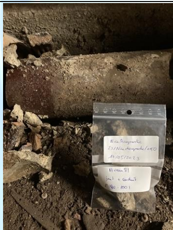
Photo n° PhA190 Localisation : MJA - MJA170 - NIVEAU : S1 - CSTC01 - LOC-TECH Ouvrage : Conduits de fluides (air, eau, autres fluides) Partie d'ouvrage : Conduits Description : Conduits + Joint
