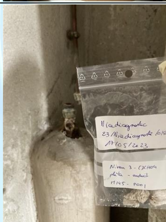
Photo n° PhA145 Localisation : MJA - MJA170 - NIVEAU : 03 - C3CH04 - VACANT Ouvrage : Conduits de fluides (air, eau, autres fluides) Partie d'ouvrage : Enveloppes de calorifuges Description : Enveloppes de calorifuges plâtre
