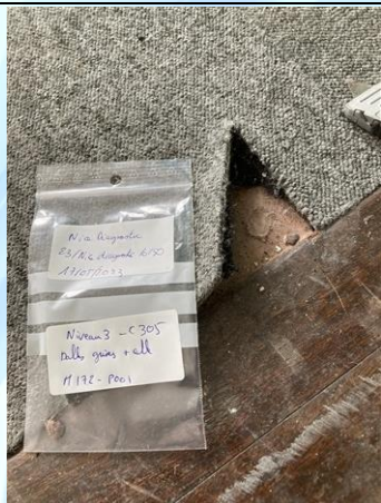
Photo n° PhA172 Localisation : MJA - MJA170 - NIVEAU : 03 - C305 - VACANT Ouvrage : 5 - Planchers et planchers techniques - Revêtements de sols Partie d'ouvrage : Dalle de sol Description : Dalles de moquette + Colle
