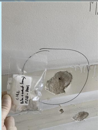
Photo n° PhA233 Localisation : MJA - MJA170 - NIVEAU : 01 - C142 - VACANT Ouvrage : 3 - Parois verticales intérieures - Murs et cloisons maçonnés Partie d'ouvrage : Enduit à base de plâtre lissé ou taloché Description : Béton + Enduit (Mur)
