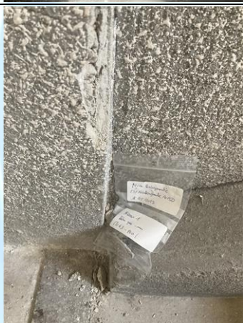
Photo n° PhA043 Localisation : MJA - MJA170 - NIVEAU : 01 - C1CH02 - VACANT Ouvrage : 3 - Parois verticales intérieures - Murs et cloisons maçonnés Partie d'ouvrage : Enduit à base de plâtre lissé ou taloché Description : Béton + Enduit Gris (Mur)
