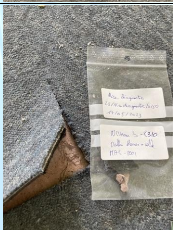
Photo n° PhA175 Localisation : MJA - MJA170 - NIVEAU : 03 - C310 - VACANT Ouvrage : 5 - Planchers et planchers techniques - Revêtements de sols Partie d'ouvrage : Dalle de sol Description : Dalle de moquette + Colle
