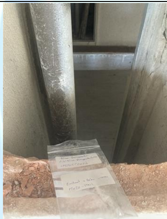
Photo n° PhA026 Localisation : MJA - MJA170 - NIVEAU : 00 - C016-18 - VACANT Ouvrage : 3 - Parois verticales intérieures - Murs et cloisons maçonnés Partie d'ouvrage : Enduit à base de plâtre lissé ou taloché Description : Enduit + Béton (Mur)
