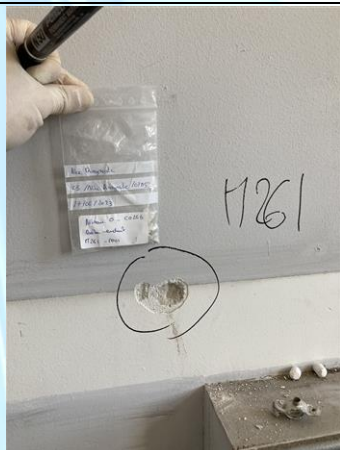
Photo n° PhA268 Localisation : MJA - MJA170 - NIVEAU : 00 - C026b - VACANT Ouvrage : 3 - Parois verticales intérieures - Murs et cloisons maçonnés Partie d'ouvrage : Enduit à base de plâtre lissé ou taloché Description : Béton + Enduit (Mur)
