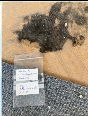
Photo n° PhA117 Localisation : MJA - MJA170 - NIVEAU : 02 - C206-14 - VACANT Ouvrage : 5 - Planchers et planchers techniques - Revêtements de sols Partie d'ouvrage : Dalle de sol Description : Feutre noir + Colle
