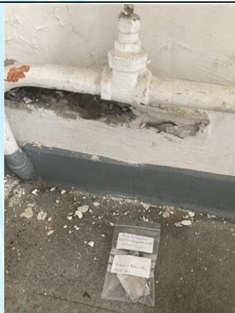
Photo n° PhA028 Localisation : MJA - MJA170 - NIVEAU : 00 - C027 - VACANT Ouvrage : 3 - Parois verticales intérieures - Murs et cloisons maçonnés Partie d'ouvrage : Enduit à base de plâtre lissé ou taloché Description : Enduit + Béton (Mur)
