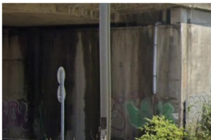
Humidité sur le mur de front de la culée
