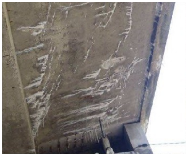
Efflorescence sur l'encorbellement
