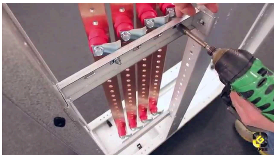
Type de jeux de barre en cuivre à installer
