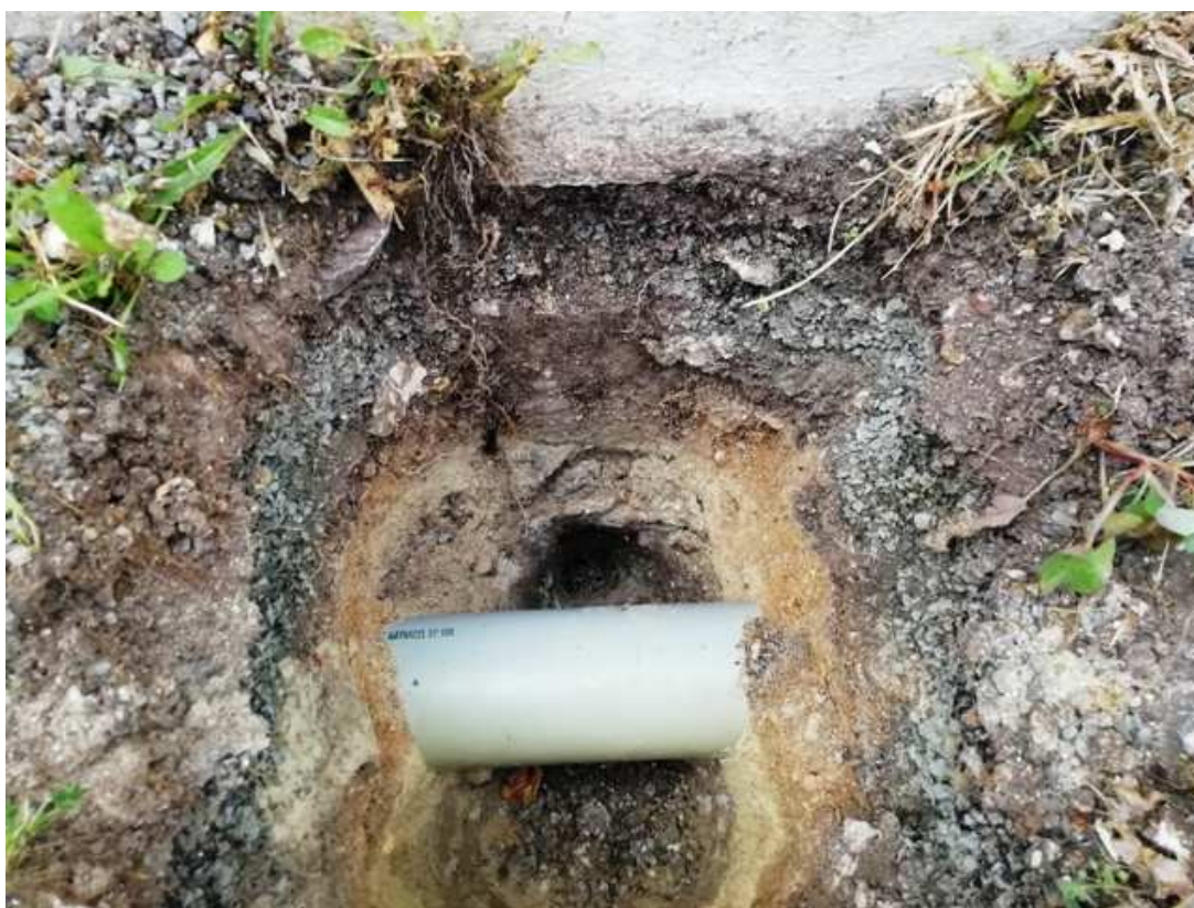
Photo 1 : Photo de la reconnaissance des fondations de l'existant (RF1).
