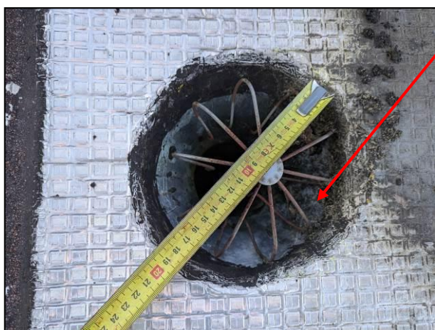
Entrée d'eaux pluviales verticale cylindrique de Ø 80 mm Absence de système d'arrêt des débris
