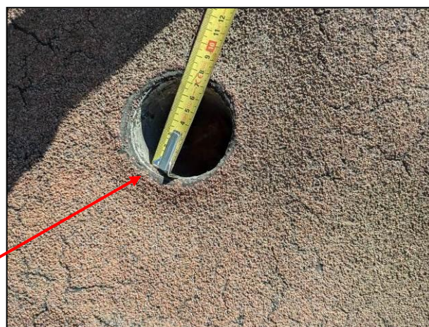
Entrée d'eaux pluviales verticale tronconique de Ø 90/180 équipée d'un système d'arrêt des débris de type crapaudine
