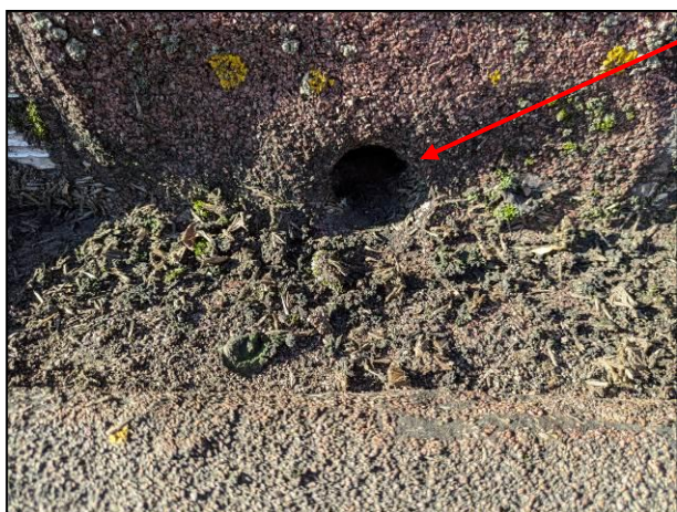
Entrée d'eaux pluviales verticale tronconique de Ø 90/180 équipée d'un système d'arrêt des débris de type crapaudine
