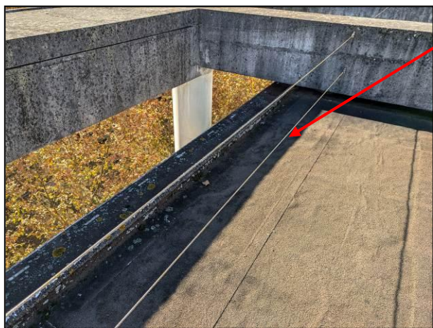
La hauteur des garde-corps est insuffisante et non conforme aux normes en vigueur
