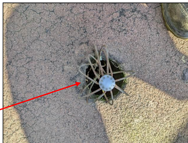
Entrée d'eaux pluviales verticale cylindrique de Ø 80 mm Absence de système d'arrêt des débris
