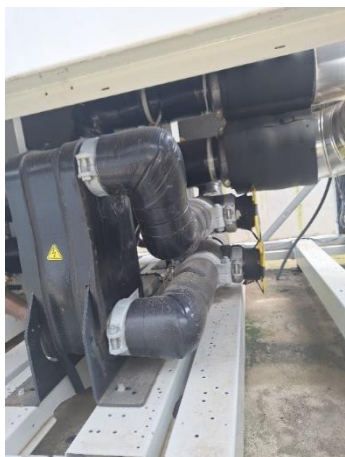
Figure 3 : Echangeur du groupe froid (gauche) – Passage laissé en attente (droite)
