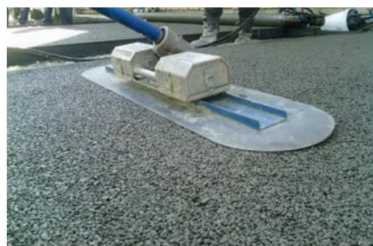
Photo 51 - Passage de la lisseuse vibrante.
