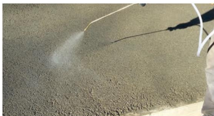
Photo 58 : Protection du béton drainant à l'aide d'un produit de cure spécifique.
