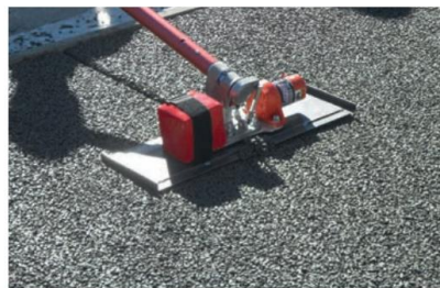
Photos 59 et 60 - Exécution des joints dans le matériau frais à l'aide d'un rouleau jointeur (à gauche) ou d'une jointeuse vibrante
