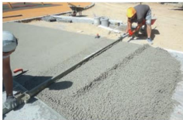
Photo 48 - Nivellement à la règle manuelle.
