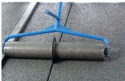
Photos 59 et 60 - Exécution des joints dans le matériau frais à l'aide d'un rouleau jointeur (à gauche) ou d'une jointeuse vibrante
