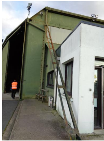
FLECHISSEMENT ET CORROSION DES TIRANTS (SOURCE : DIAGNOSTIC STRUCTURE)
