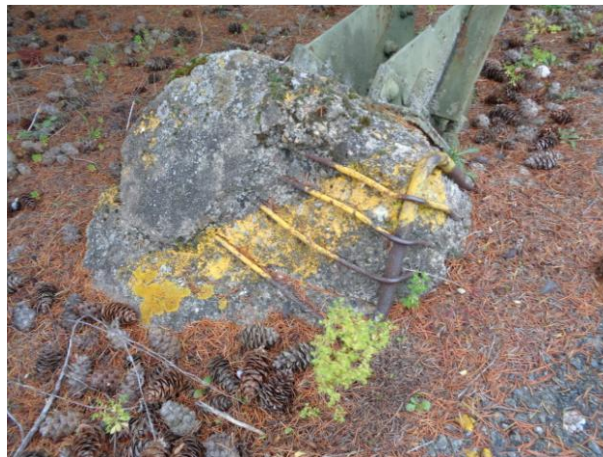
ÉCLAT DU BETON ET PERTE DE MATERIAUX (SOURCE : DIAGNOSTIC STRUCTURE)
