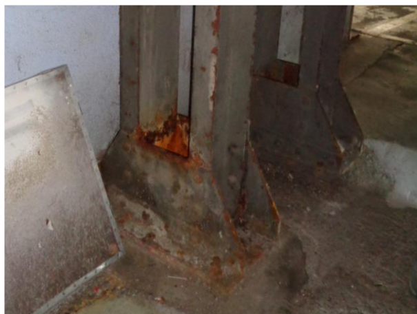
ENROUILLEMENT ET CORROSION (SOURCE : DIAGNOSTIC STRUCTURE)
