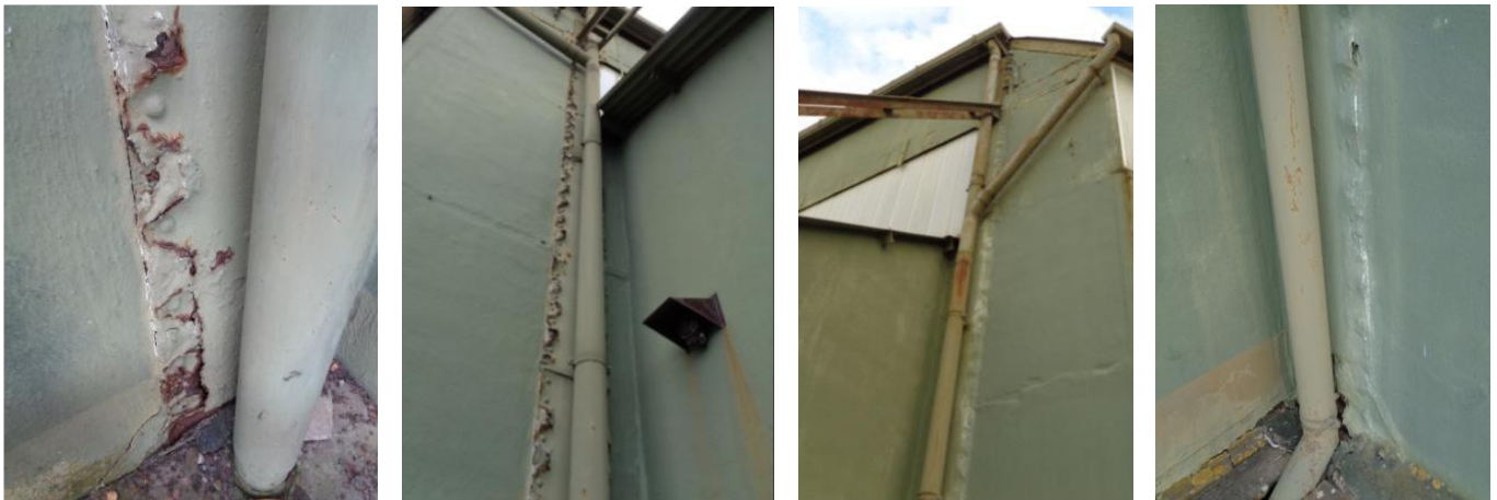
ENROUILLEMENT ET CORROSION AVANCEE (SOURCE : DIAGNOSTIC STRUCTURE)
