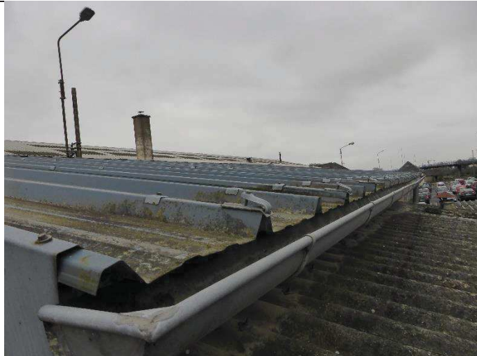
4 – Bac aciers Aile Est. Traces de mousse à nettoyer.
