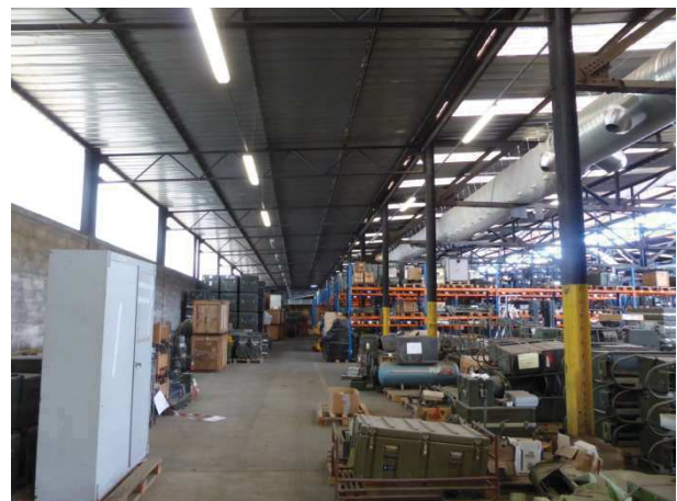
6 - Présence de plusieurs poutre au vent dont une à chaque extrémité du bâtiment.
