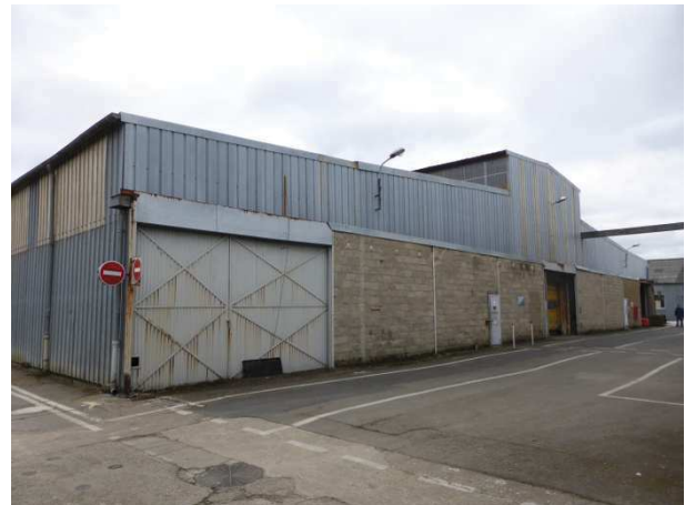
4 - Appentis de rive. Pas de présence de lien de maintien hors plan des pannes ni de contreventement
