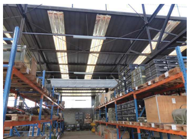
6 - Présence de plusieurs poutre au vent dont une à chaque extrémité du bâtiment.
