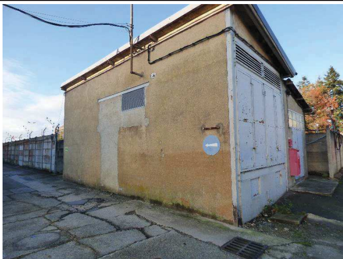
3 – Gouttière en bas de pente aile Est. Couverture amiantée sur aile Ouest.
