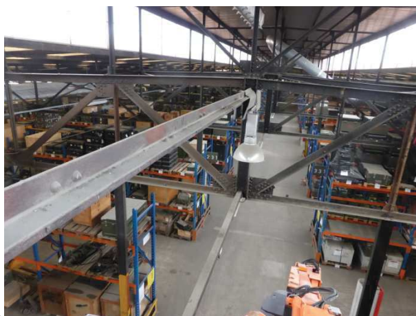
5 - Ferme treillis principale comprenant une surélévation sur toute la longueur du bâtiment
