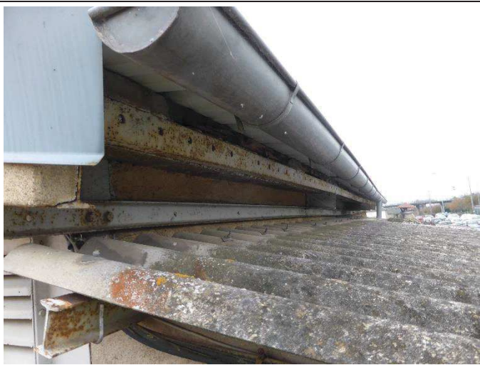
3 – Gouttière en bas de pente aile Est. Couverture amiantée sur aile Ouest.
