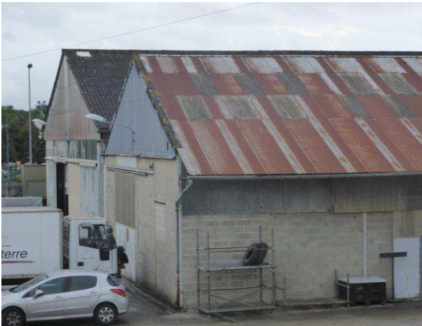
3 - Vue générale de l'ensemble de la charpente - Présence d'une cloison bardée à l'axe du faîtage
