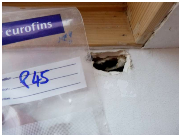
Prélèvement - P45 : 1er Etage / Bureau 8 - Panneau collé ou vissé- (Absence d'amiante)
