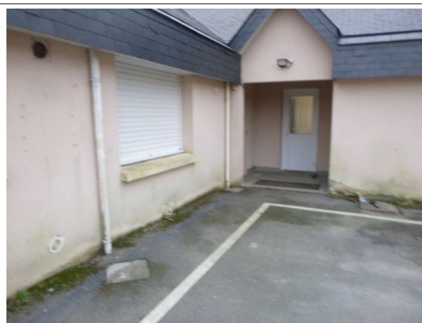
Déclaré - : Extérieurs / Toitures - Conduit d'eau pluviale- (Absence d'amiante)
