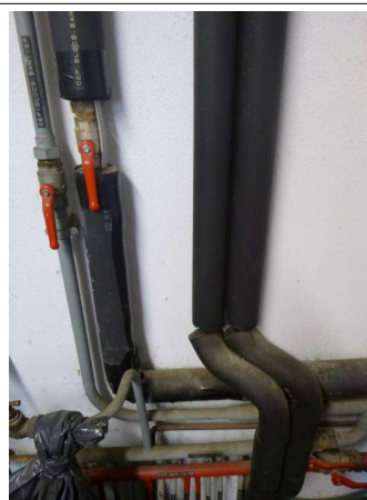
Déclaré - : Rez-de-chaussée / Local Chaudière - Calorifugeage - (Absence d'amiante)
