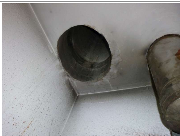
Déclaré - : Rez-de-chaussée / Local Chaudière - Conduit de ventilation- (Absence d'amiante)
