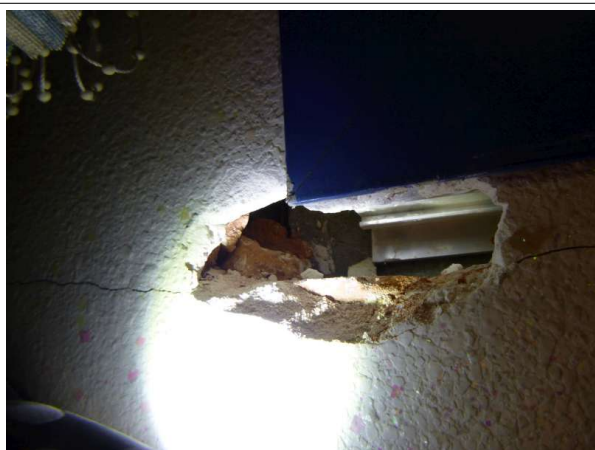
Déclaré - : Rez-de-chaussée / Bureau 5 - Joint d'étanchéité entre menuiserie et structure- (Absence d'amiante)
