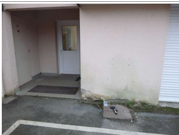
Prélèvement - P15 : Extérieurs / Façades - Enduit projeté- (Absence d'amiante)
