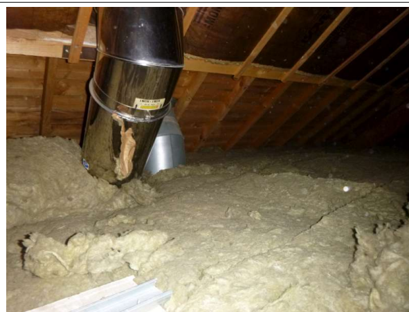
Déclaré - : Combles / Combles Perdus Haut Ouest - Conduit de fumée- (Absence d'amiante)
