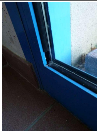
Prélèvement - P52 : Rez-de-chaussée / Sas d'Entrée 2 - Joint- (Absence d'amiante)
