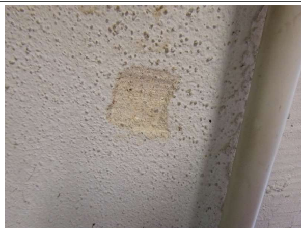
Prélèvement - P06 : Rez-de-chaussée / Local Chaudière - Enduit projeté- (Absence d'amiante)
