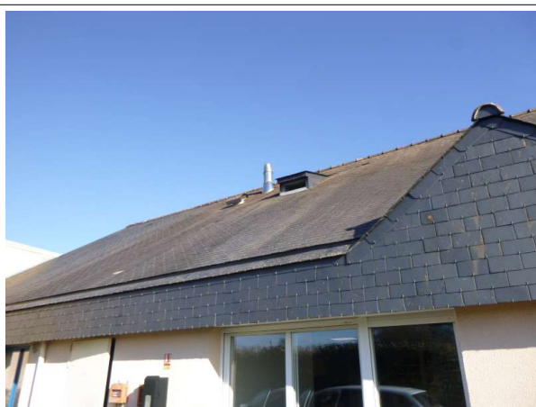
Déclaré - : Extérieurs / Toitures - Ardoise- (Absence d'amiante)
