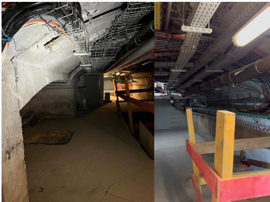
Photographies des cheminements CFO/CFA situés au sous-sol
