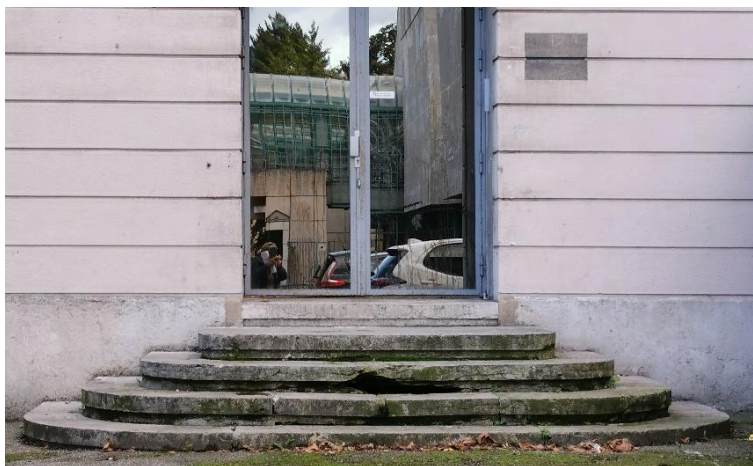
Emmarchement de l'escalier principal, pierre cassées et altérées par endroits
