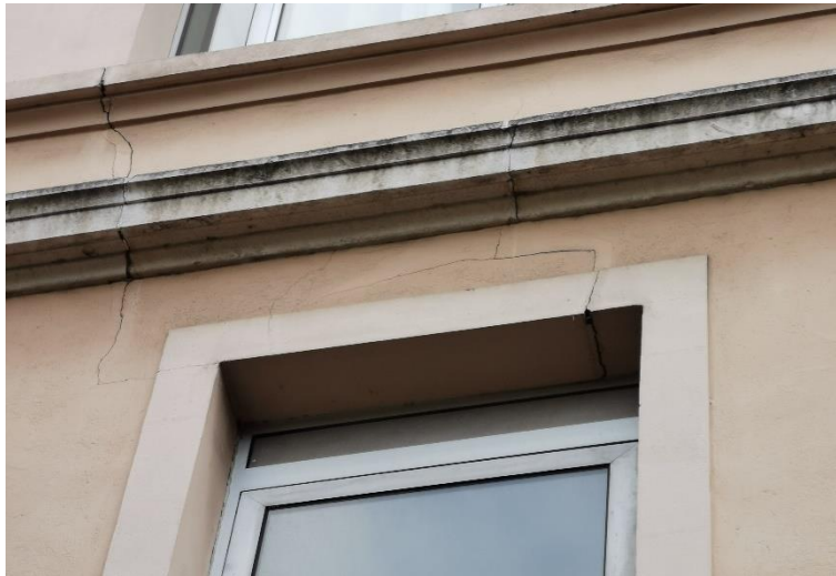
Façade Nord, 1 er étage, fissures et encrassement au droit des bandeaux en pierre
