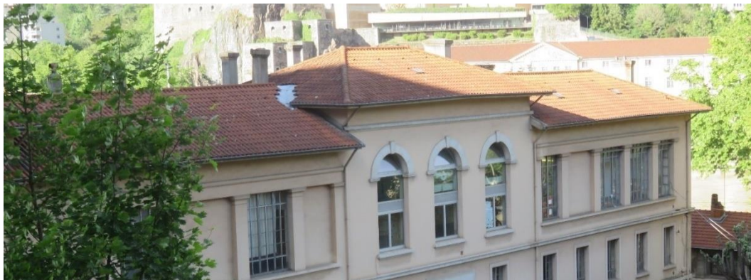
Façade Sud : couverture en tuiles creuses et tabatières d'accès aux toitures
