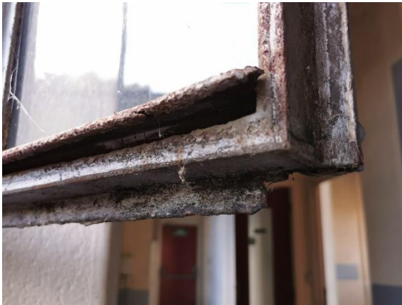
Détail ouvrant métallique corrodé
