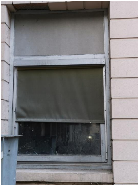
Façade nord, fenêtres remplacées (alu) et baies modifiées
