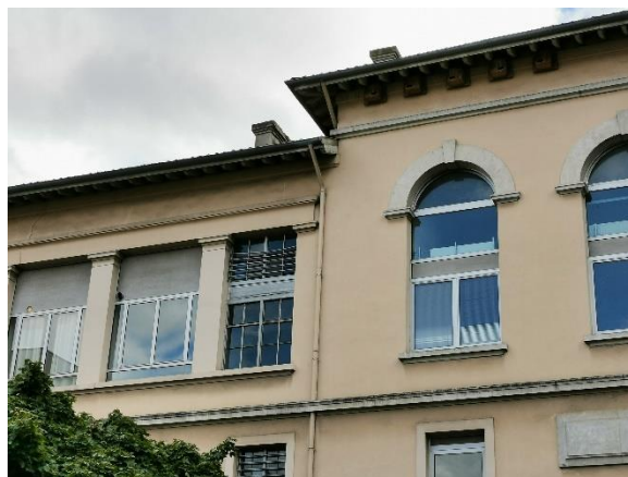
Façade nord, fenêtres remplacées (alu) et baies modifiées
