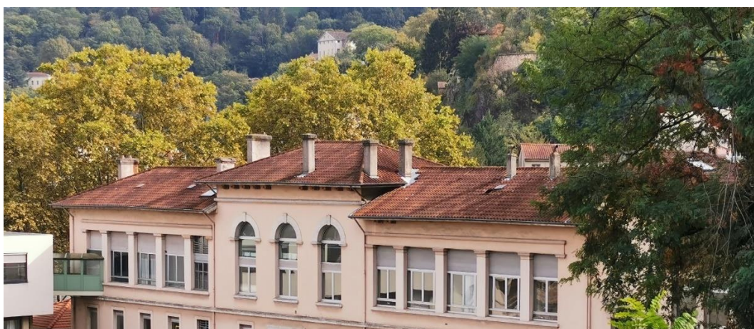
Façade Nord : couverture en tuiles creuses, tabatières d'accès aux toitures et cheminées en maçonneries enduites
