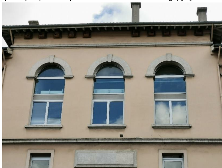
Façade nord, pavillon central, fenêtres hautes récentes en aluminium, avec redécoupage de la baie suite à la création d'un niveau supplémentaire.
