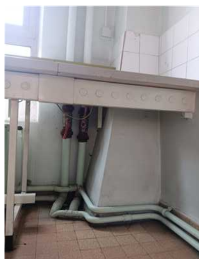
Colonne montante zone Ouest avec vannes d'isolement •
