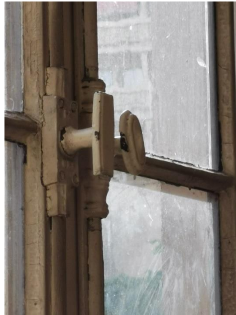
Crémone de gauche remplacée
