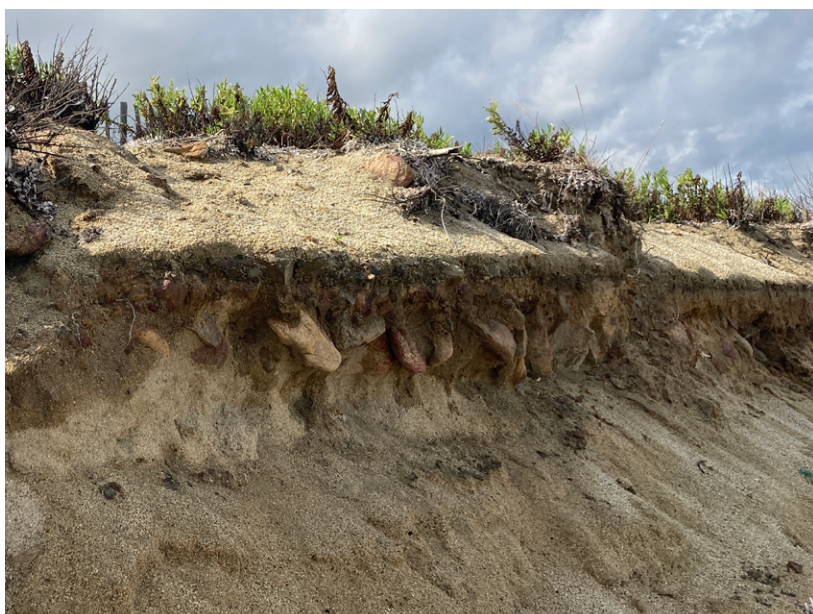
Ancienne route Les matériaux constituant l'ancienne route ont été mis à jour par les tempêtes (remblai terreux, pierres de calade)
