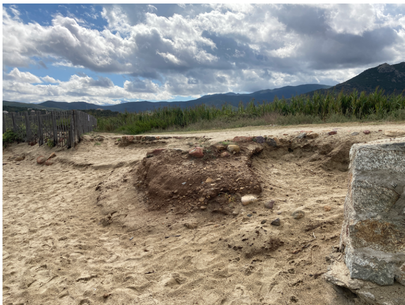
Accès à la plage N°1 fortement érodé, sol terreux et restes de calade de pierre Fondation du muret déchaussée
