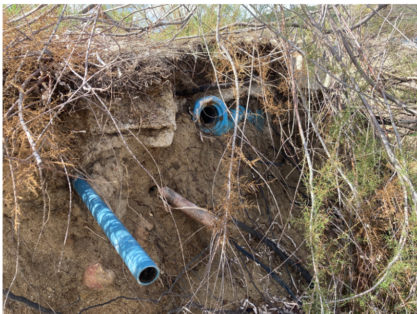
Ancienne paillote «Vavahu» Gravats, canalisations, câbles et cuve enfouie dans la dune ont réapparus suite à l'érosion de la dune
