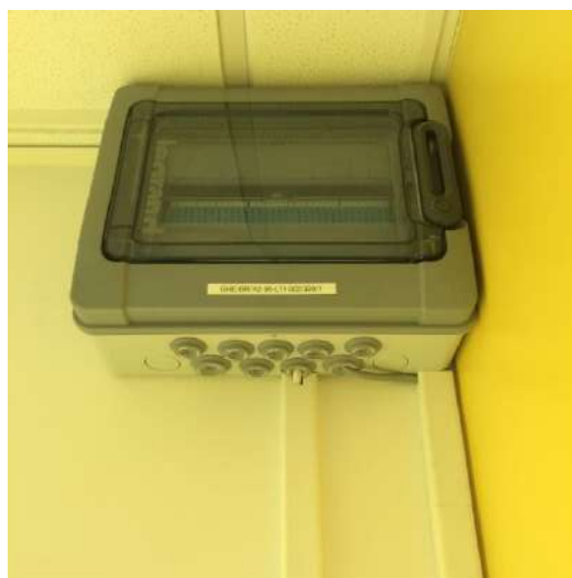
Figure 3 : Boitier d'éclatement en détail
