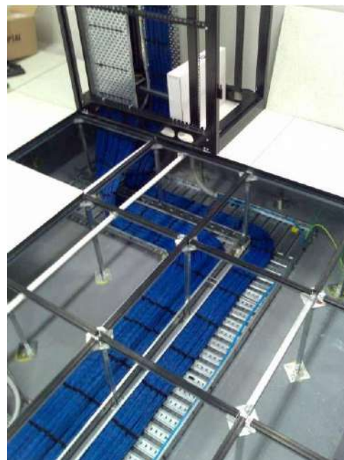
Exemple de chemins de câble dans un faux plancher technique
