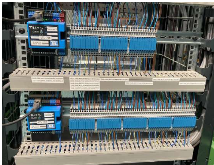
UTL de contrôle d'accès dans une baie, en face avant
