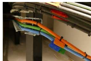
Etiquetage dans un chemin de câbles
