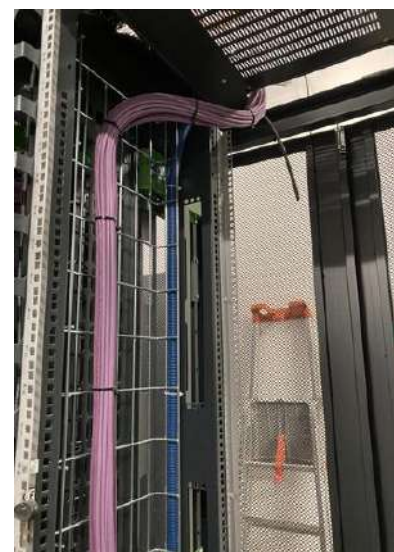
Cablofil dans les baies passives
