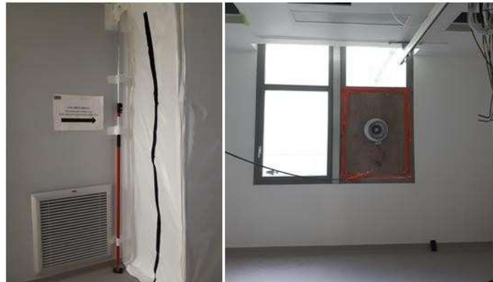
Figure : Exemple de confinement - Système de mise en dépression
