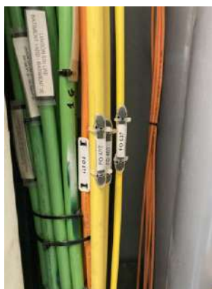
Exemple d'étiquetage attendu de fibres optiques dans une gaine technique verticale
