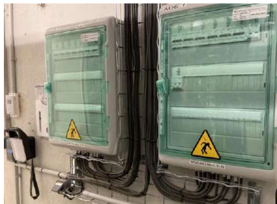
Exemple de coffret électrique pour un LCB
