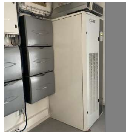
Exemple de climatisation dans un LCB
