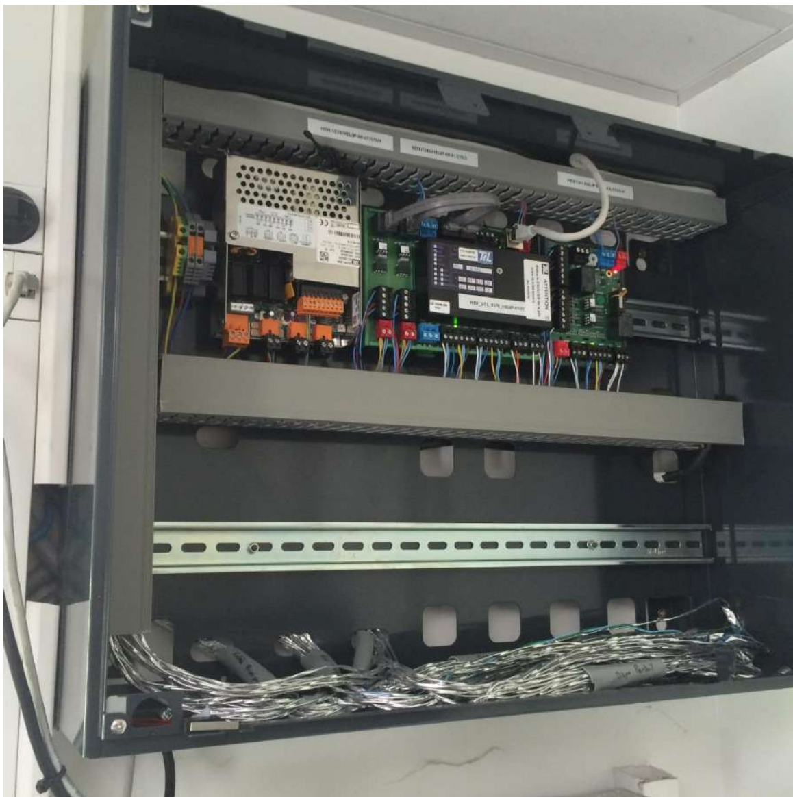
Figure 7 : Exemple d'un coffret TIL avec Alim 12 Vdc, et 1 UTL. Dans l'architecture en étoile, le module déporté MDP1 ou MDP2 est placé dans le coffret, à côté de l'UTL
