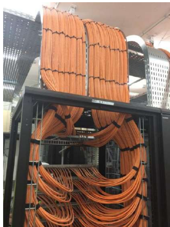
Exemple de « dégueuloir » et d'arrivée des câbles Ethernet sur les bandeaux RJ45
