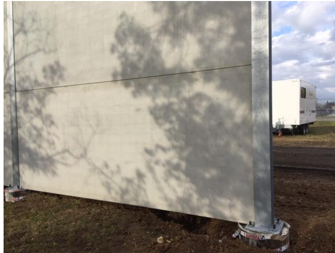
Figure 2 : Exemple de solution retenue ; plaques béton glissées dans les HEA/UPN. PBM.fr
