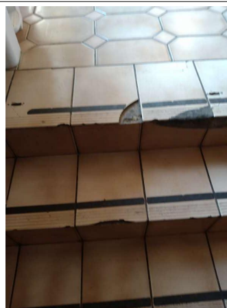
Prélèvement - P024 : BAT 0026 / R+1 / LOCAL 09 - Colle de carrelage- (Absence d'amiante)
