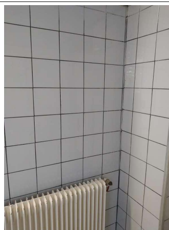
Prélèvement - P034 : BAT 0026 / R+1 / LOCAL 12 - Colle de faïence- (Absence d'amiante)
