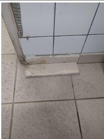
Prélèvement - P003 : BAT 0026 / RDC / LOCAL 09 - Colle de plinthe- (Absence d'amiante)
