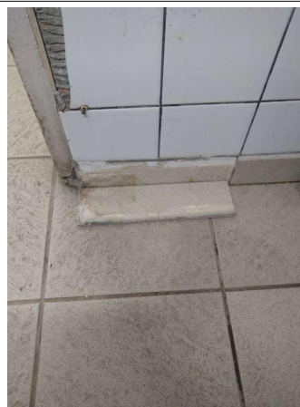
Prélèvement - P032 : BAT 0026 / R+1 / LOCAL 12 - Colle de plinthe- (Absence d'amiante)
