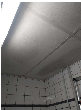
Prélèvement - P007 : BAT 0026 / RDC / LOCAL 08 - Faux plafond- (Absence d'amiante)
