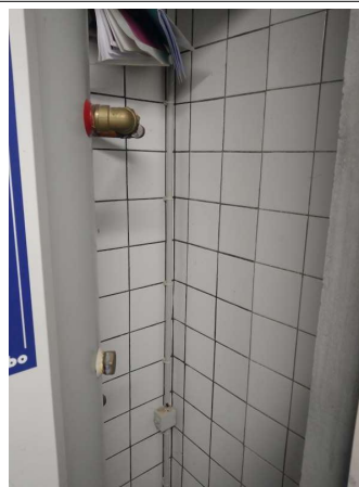
Prélèvement - P008 : BAT 0026 / RDC / LOCAL 07 - Colle de faïence- (Absence d'amiante)
