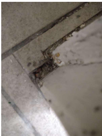
Prélèvement - P029 : BAT 0026 / R+1 / LOCAL 07B - Colle de carrelage- (Absence d'amiante)
