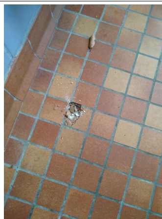
Prélèvement - P036 : BAT 0026 / R+1 / LOCAL 10 - Colle de carrelage- (Absence d'amiante)
