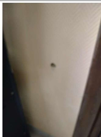
Prélèvement - P018 : BAT 0026 / RDC / LOCAL 11 - Enduit- (Absence d'amiante)
