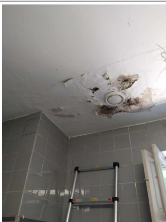
Prélèvement - P035 : BAT 0026 / R+1 / LOCAL 12 - Enduit- (Absence d'amiante)
