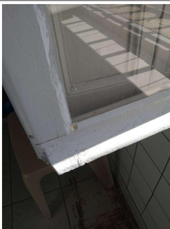
Prélèvement - P019 : BAT 0026 / RDC / LOCAL 04B - Mastic- (Absence d'amiante)
