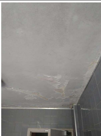
Prélèvement - P039 : BAT 0026 / R+1 / LOCAL 10 - Enduit- (Absence d'amiante)
