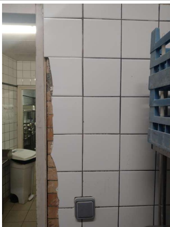
Prélèvement - P001 : BAT 0026 / RDC / LOCAL 09 - Colle de faïence- (Absence d'amiante)
