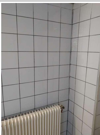
Prélèvement - P033 : BAT 0026 / R+1 / LOCAL 12 - Colle de faïence- (Absence d'amiante)
