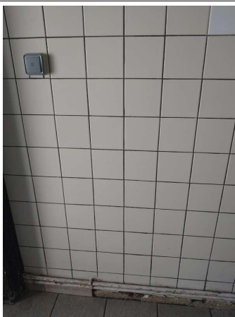
Prélèvement - P025 : BAT 0026 / R+1 / LOCAL 07A - Colle de faïence- (Absence d'amiante)
