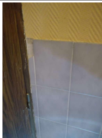
Prélèvement - P014 : BAT 0026 / RDC / LOCAL 10 - Colle de faïence- (Absence d'amiante)
