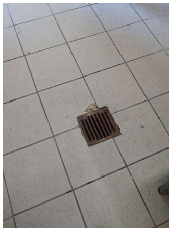
Prélèvement - P030 : BAT 0026 / R+1 / LOCAL 12 - Colle de carrelage- (Absence d'amiante)
