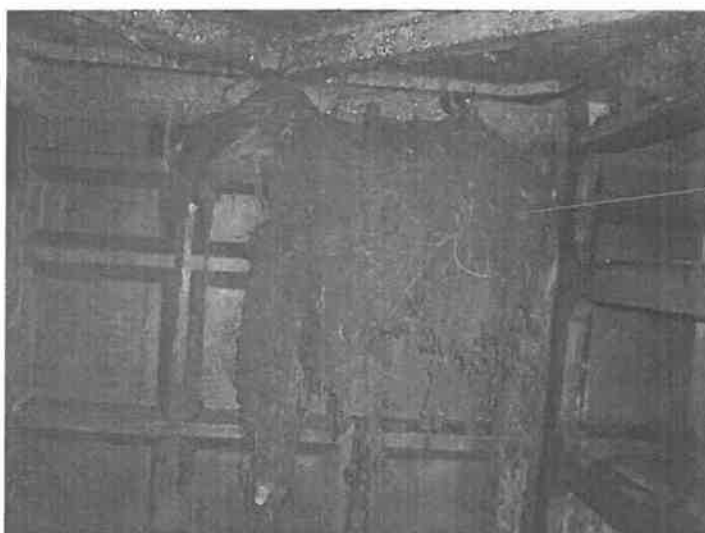
Forte pénétration de racines au niveau de l'arbre.
