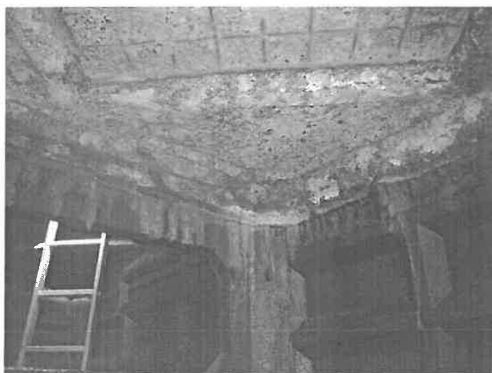
Détérioration de la partie haute du vraisemblablement a une présence d'H 2 S.
