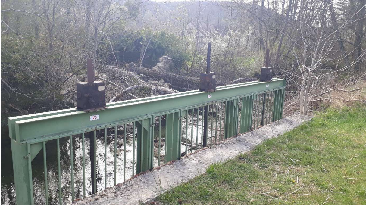
Figure 7 : Vannes d'évacuation en rivière.
