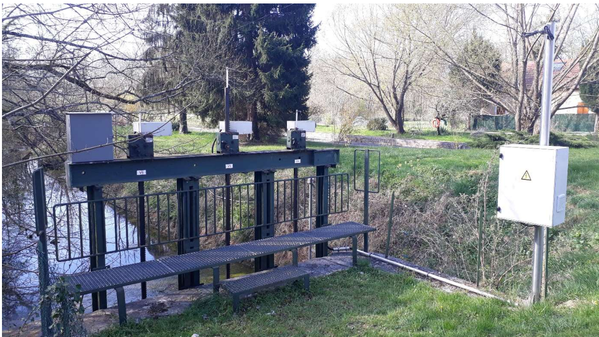
Figure 4 : Vanne d'alimentation pour le canal.
