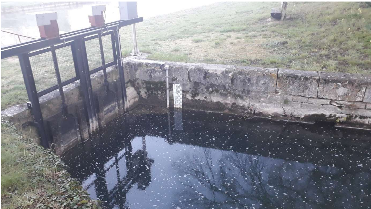
Figure 5 : Sonde de niveau ru de Baon
