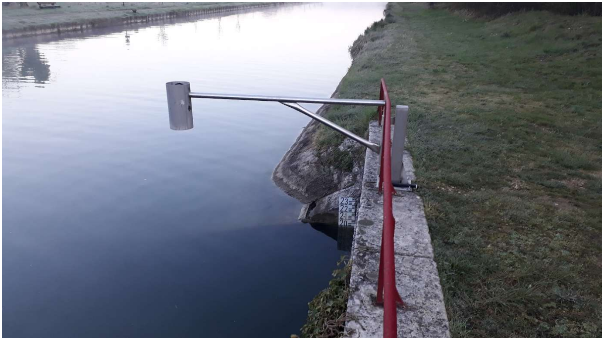
Figure 6 : Sonde radar aval prise d'eau
