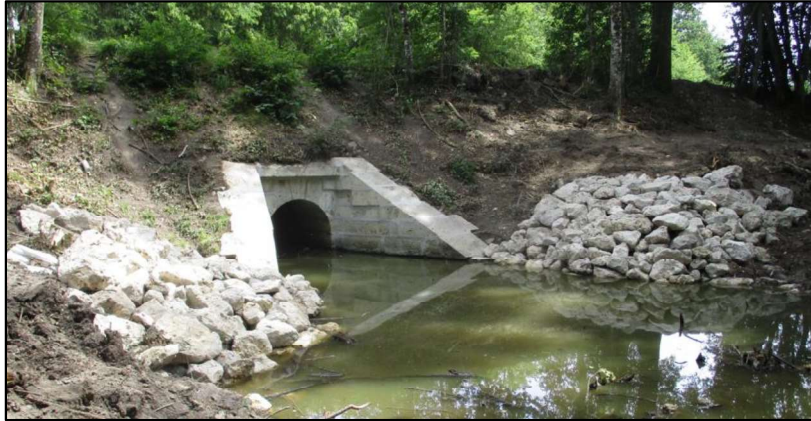
Figure 2 : Exemple de comblement de zones affouillées par enrochements
