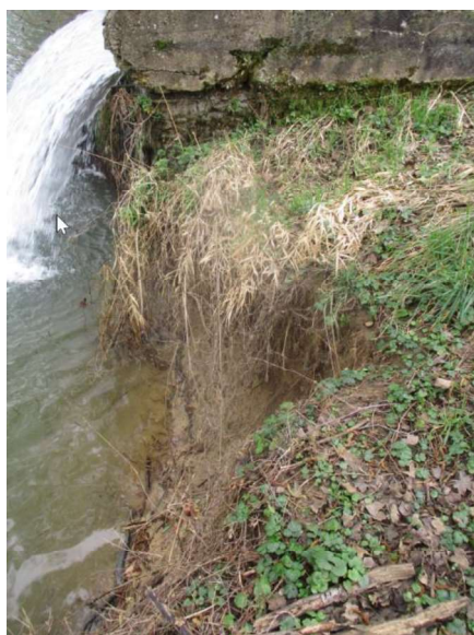
Figure 3 : Erosions de berges sur le déchargeoir Rougemont (à g.) et le déchargeoir Commissey (à d.) à recharger (source : ARTELIA,2024)
