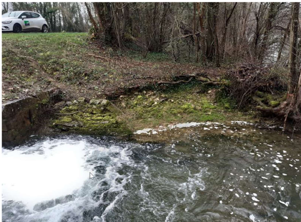
Figure 4 : Erosions de berges sur le déchargeoir Dannemoine : ancien perré à restaurer par recharges (source : ARTELIA,2024)
