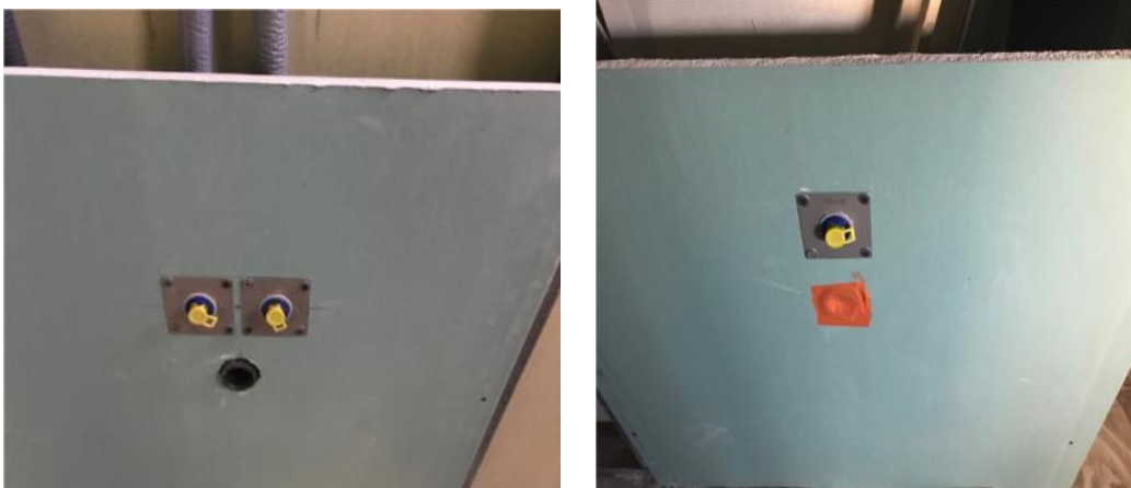
Exemple de mise en place des attentes en cloisons
