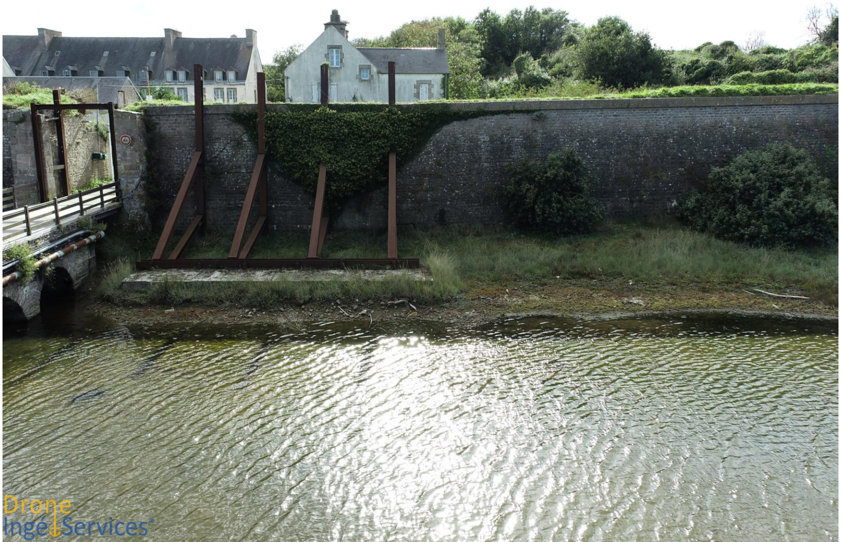
Vue, vers le Sud, du mur de courtine Ouest et de son étaieement par butons métalliques
