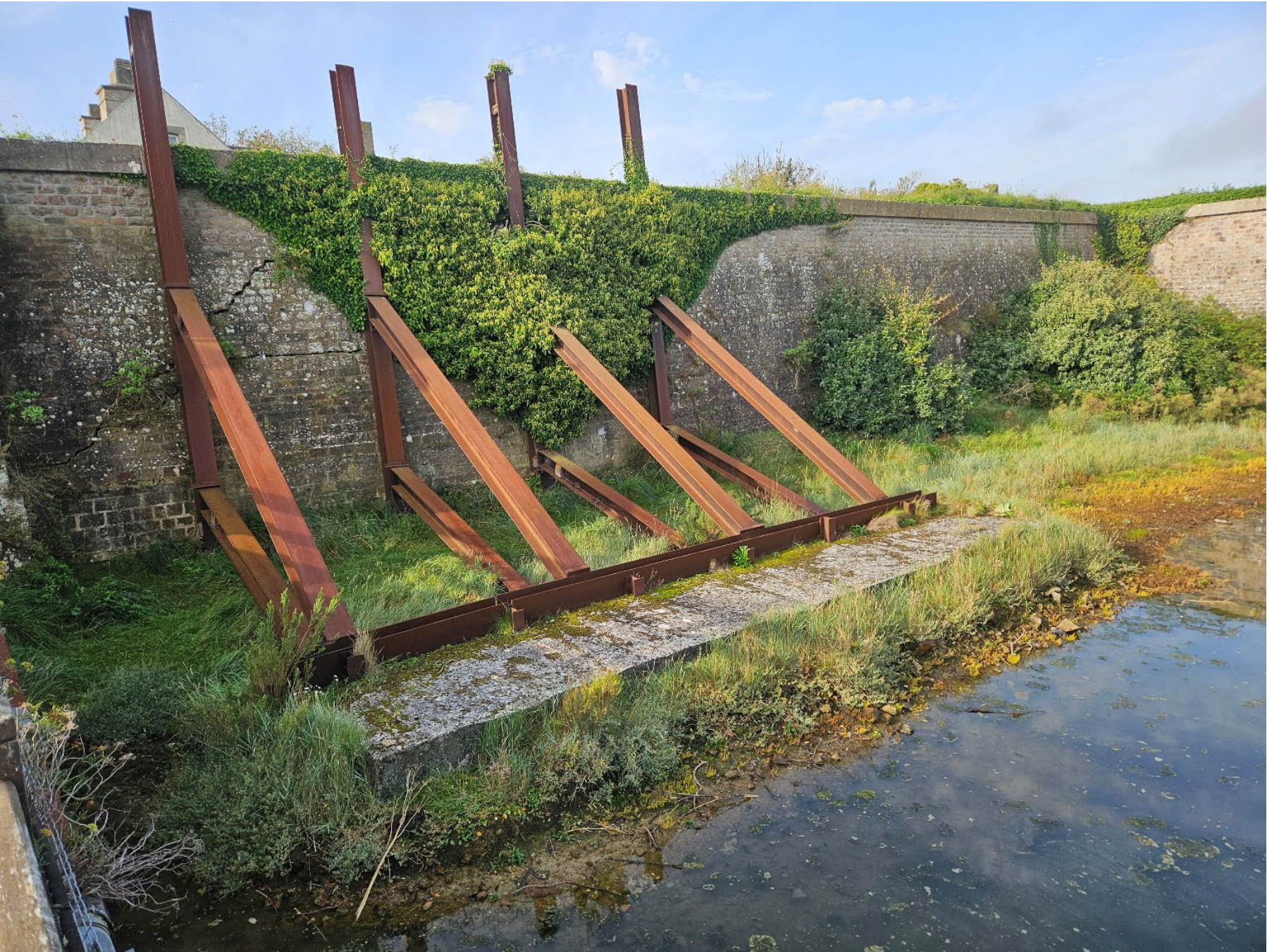
7. Étalement métallique au-devant de la zone confortée.
