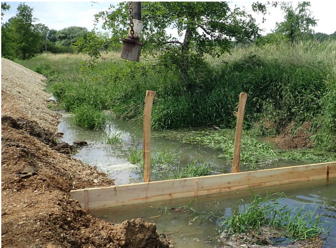
Figure 5. Exemple d'implantation en cours d'un tunage bois en amont d'un secteur rectiligne à combler, ici en eau alors que le Bief des Grusses sera à sec au moment des travaux) ;
