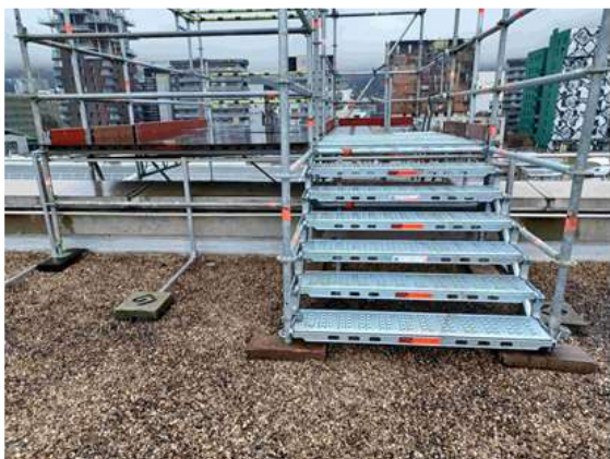
La sapine d'accès dessert la toiture terrasse non accessible
