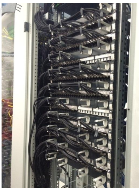
Exemple de câblage de baie passive
