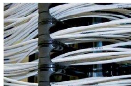
Exemple de passage des câbles entre la baie active et la baie passive
