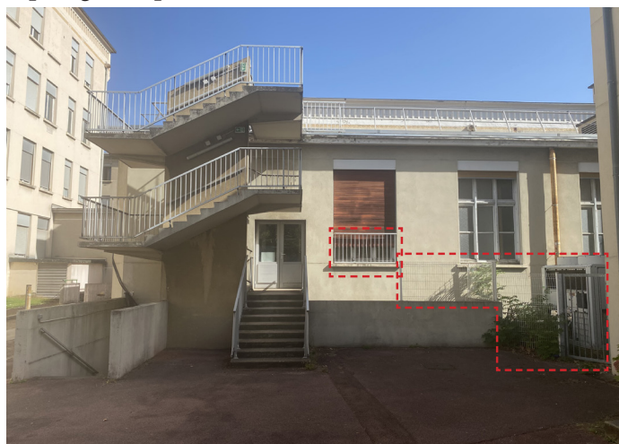
Figure 15 : Garde-corps et lisses parasites à déposer, photographies, pavillon A, Agence Goutal, 2023.
