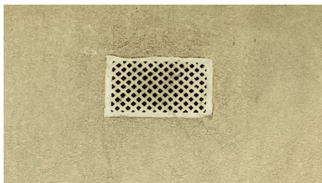
Figure 32 : Grilles en terre cuite modèles originaux déposés en conservation (réserves des HCL, ancien bâtiment des machines et chaudières) à réemployer ou à refaire fabriquer (suivant ce modèle) pour le pavillon A, photographies, Agence Goutal, 2024.
