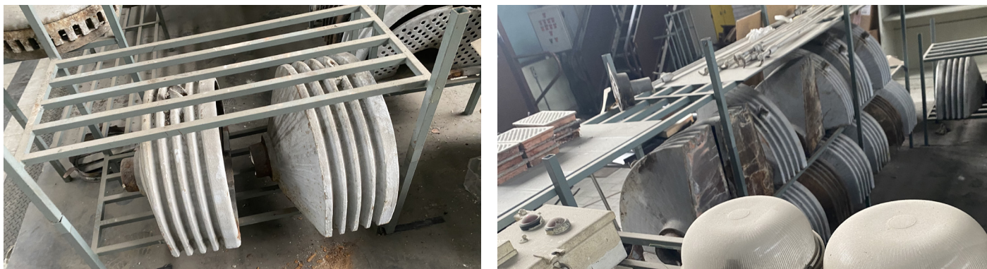
Figure 34 : Crapaudines et boîtes à eau (demi-rond et quart de rond) en fonte modèles originaux déposés en conservation (réserves des HCL, ancien bâtiment des machines et chaudières) à réemployer pour le pavillon A, photographies, Agence Goutal, 2024.
