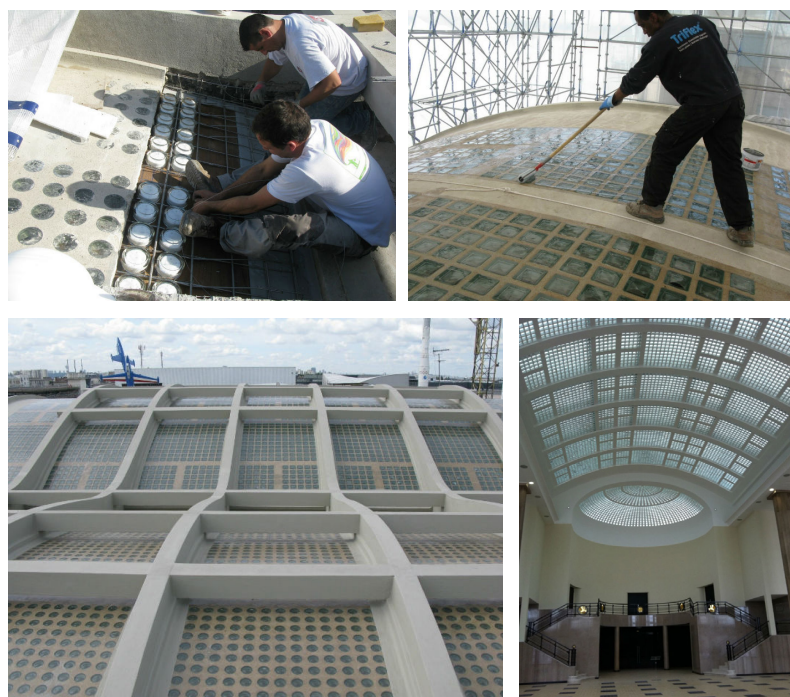
Figure 7 : Exemple d'une restauration de voûtes en béton et pavés de verre, la salle des 8 colonnes du Musée de l'air et de l'Espace, Le Bourget, Agence Goutal et ent. Sertec, 2013, https://www.sertec-etancheite.fr/ .
